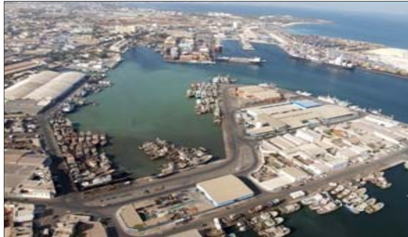
<그림 6-41> 다카 항의 어항 시설 전경
