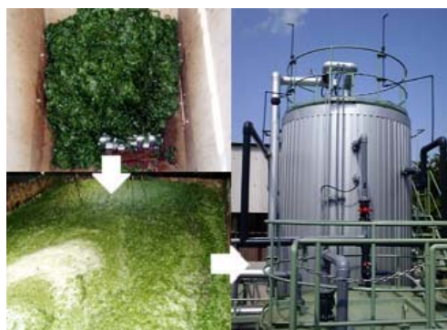
[그림 2-3-2] 일본 Tokyo Gas의 해조류를 원료로 한 메탄가스 생성공정 및 Material Balance
