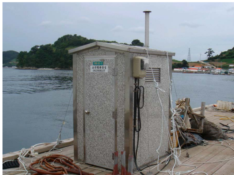
그림 9. 해상가두리양식장에 설치된 소각식 화장실
