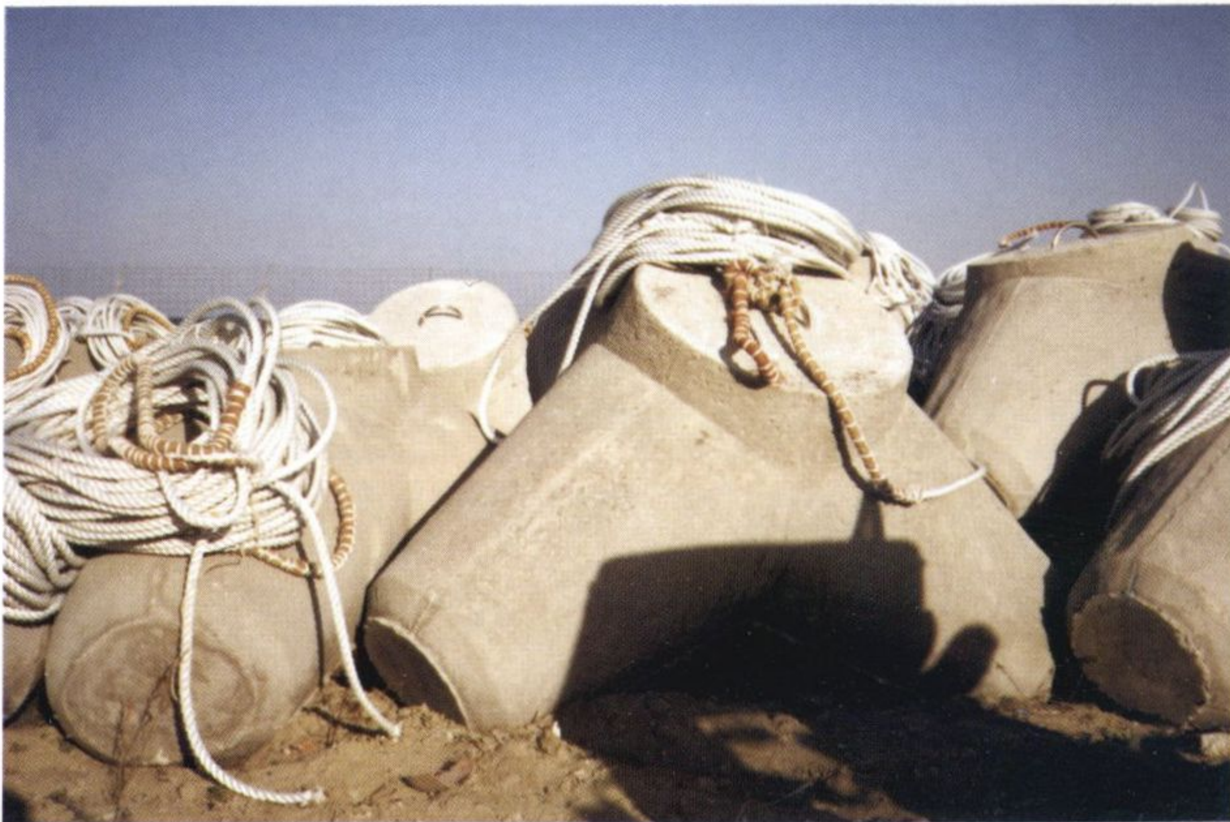
가리비 연승수하시설 삼발 콘크리트 앵카. Concrete TTP anchor for facilities of scallop culture.
