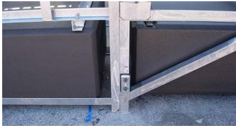
그림 242. 연결된 플로트의 조립된 하단 모습. (하 단에 부착된 부식방지용 아연희생양극)
