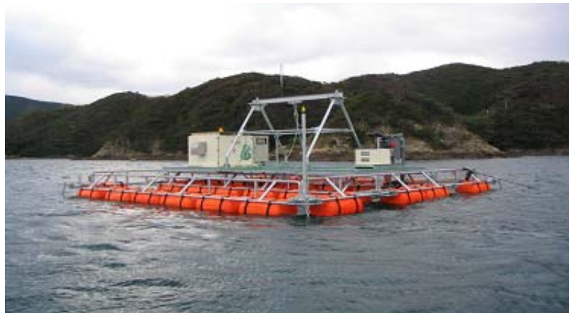
그림 233. 스티로폼 부자와 철 파이프를 사용한 플로트
