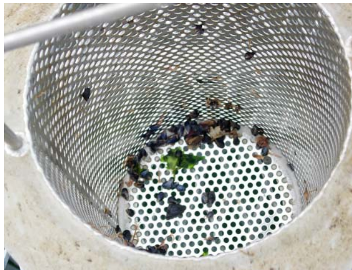
그림 271. 낙수방지 챔버내의 스트레이너 내의 이물질
