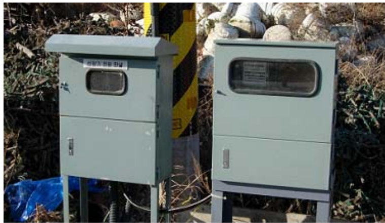
그림 257. 완공한 전기공사(전기공급판넬)
