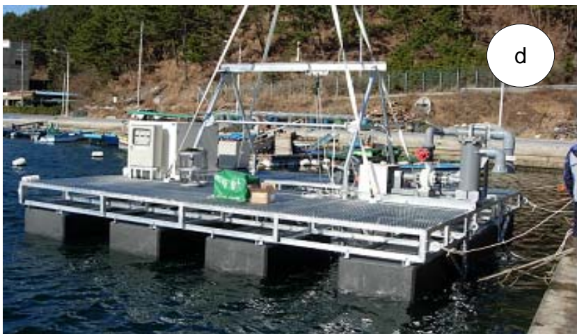
그림 220. 현장조립 후 해수면 진수. (a) 조립 완성된 장비가 탑재된 플로트 해상진수 준비, (b) 크레인으로 들어 올린 시스템 모습, (c) 진수 직전의 시스템 모습, (d) 해수면에 진수한 시스템 모습
