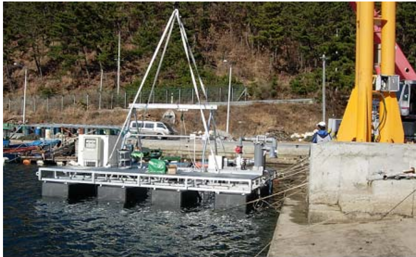
그림 244. 해수면으로의 조립 완성된 플로트 진수
