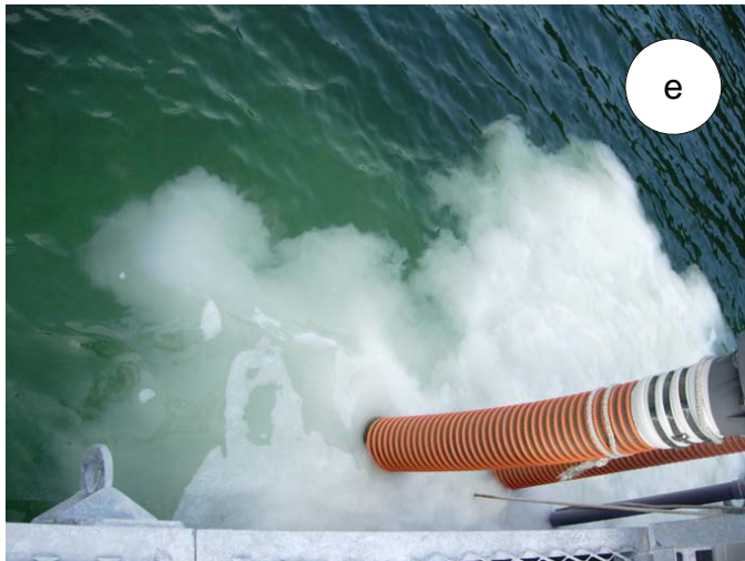
그림 327. 적조구제물질 살포 장치. (a)살포장치의 밸브 연결, (b)취수구 부근에 설치된 살포 장치, (d)수산화마그네슘 세프레마, (e)취수구로 유입되는 수산화마그네슘 수용액.
