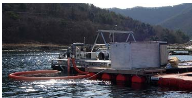
그림 250. 구동수 펌프 배관 호스의 설치
