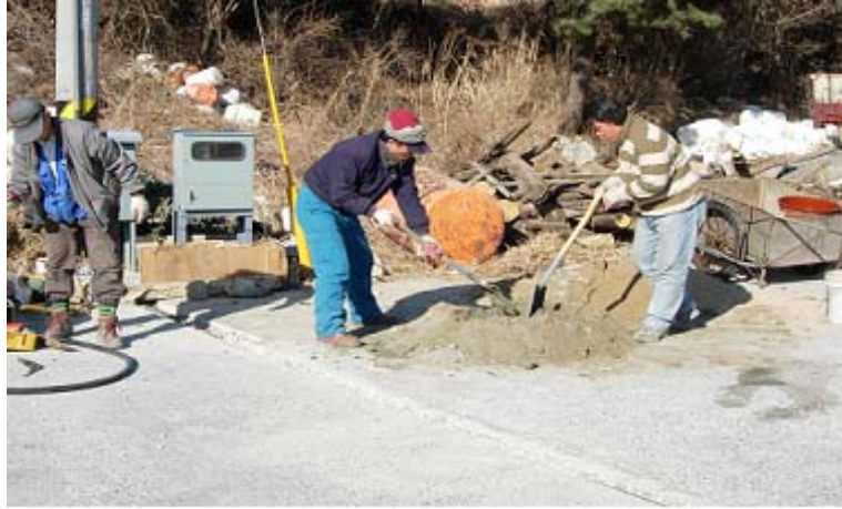
그림 256. 보호관으로 싸서 매립한 전기선에 콘크리트 작업
