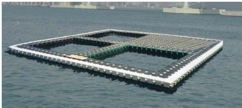
그림 100. 공기를 주입시켜 제작한 해상 부유 구조물
