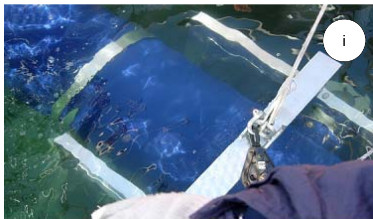
그림 247. 플로트에 수류발생장치의 인양과정. (a) 수류발생장치 침수(b) 수류발생장치 침수(c) 수류발생장치 침수(d) 수류발생장치 침수(e) 플로트내로 수류발생장치 인양(f) 플로트내로 수류발생장치 인양(g) 플로트내로 수류발생장치 인양(h) 플로트내로 수류발생장치 인양(i) 플로트내로 수류발생장치 거치
