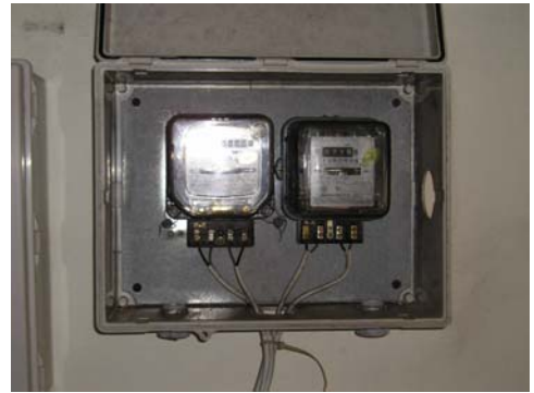
그림 43. Pilot 전복 순환여과 사육 시스템 내 전력소모 측정을 위한 전력 계량기.
