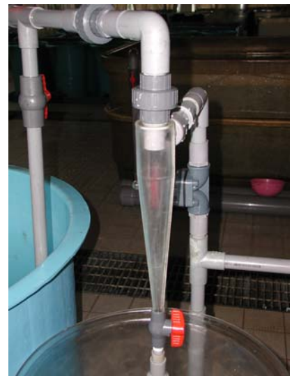
그림 18. 실험에 이용한 hydrocyclone 설치 모습.
