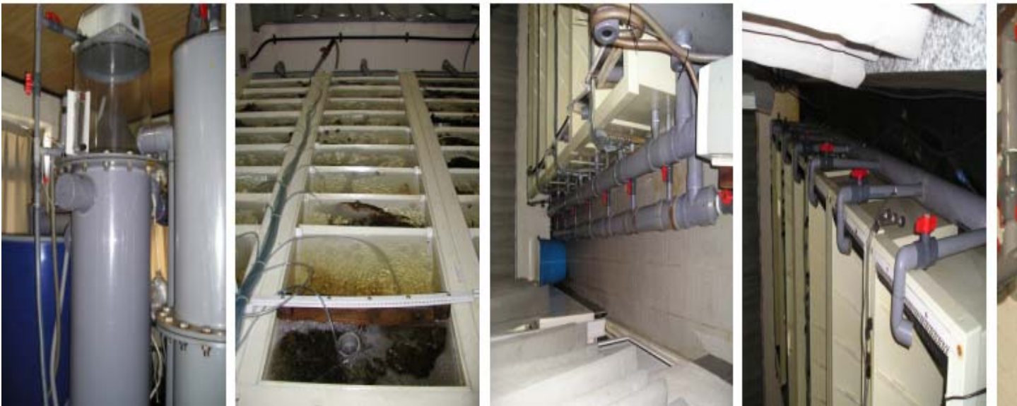
그림 50. Pilot 전복 순환여과 사육 시스템 설치 전경. a: pilot 시스템 전경, b: 저수조 및 순환펌프, c: 사육용 에어블로워, d: 포말분리기용 에어블로워, e: 포말분리기 및 모래유동층 여과조, f: 사육수조, g: 배수관, h: 배수관, i: hydrocyclone.
