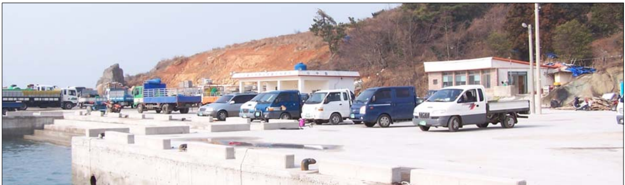
<그림 4-36> 하동어촌계 어업인대기소 건축 예정지 인근 전경
