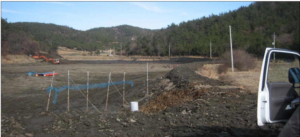
<그림 4-32> 덕산어촌계(덕산마을) 마을안길 포장 예정지 인근 전경
