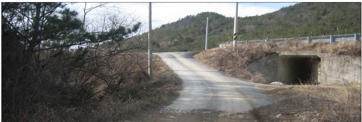
<그림 4-34> 덕산어촌계(모래금마을) 어장진입로 정비 예정지 인근 전경
