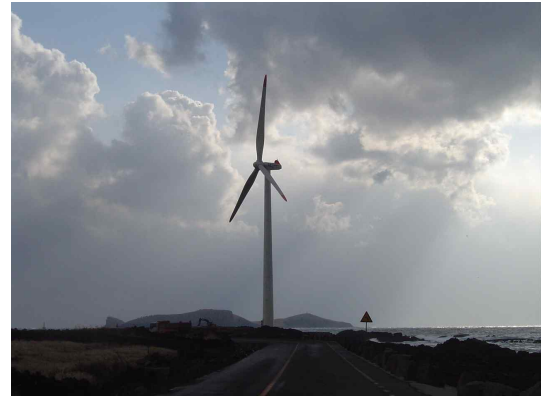
그림. 6-3-10. 환경풍력발전소 발전. Fig. 6-3-10. Wind power generator of Hankyung WP.
