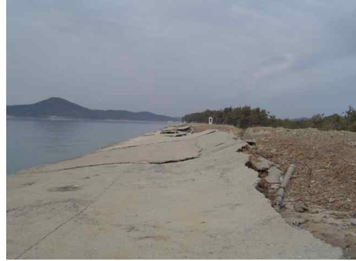
그림 6-2-9. 유실된 황포만 남단 호안. Fig. 6-2-9. Swept embankment at southern part of Hwangpo Bay.
