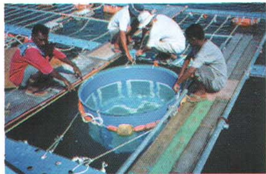
6. 해상사육용 가두리 설치작업. 6. Installation of sea cage.
