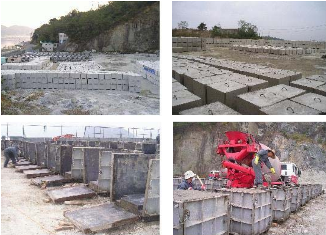
그림 3-1-1. 용승류블록 제작 및 야적장 전경
