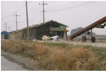
염전에 화장실 설치 안 되어 있음
