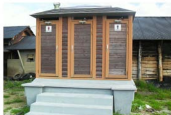
간이식 화장실 설치
