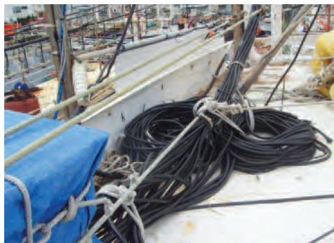
▲ 조타실 상부 초과전선 방치
