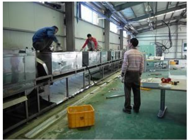
HACCP 리모델링 공사중
