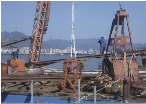
죽방렴 H빔 설치
