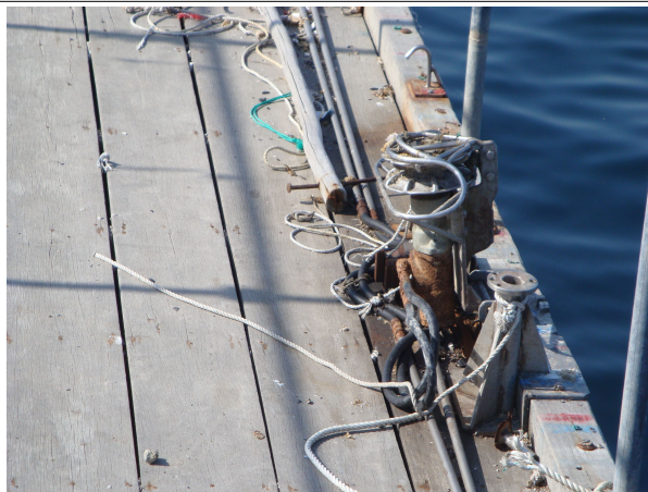
작업대에 설치된 윈줄분리기(우측)
