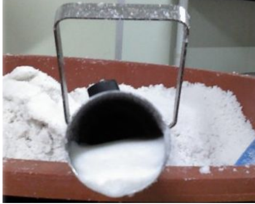
그림 22 천일염이 이송과정에서 분쇄되어 수분과 혼합됨으로써 이송관 아래쪽에 침전되어 있는 모습 . 이러한 형태로 천천히 침전되면서 궁극적으로 이송관을 막게 됨
