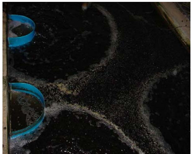
<사진 7-1-1> 경기 하나수산의 드럼스크린 및 유동층 생물여과조 운전모습.
