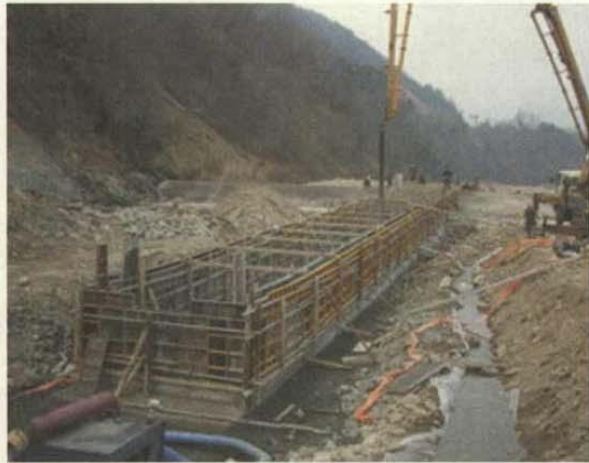
<그림 5-24> 벽체 거푸집 설치후 콘크리트 타설 전경
