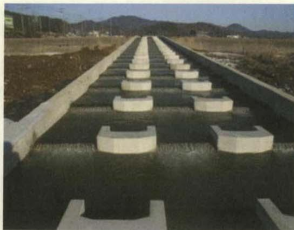
<그림 5-37> 어도블럭 조립 완료후 통수전경
