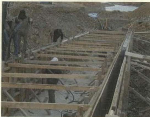
<그림 5-52> 벽체 거푸집 설치 전경
