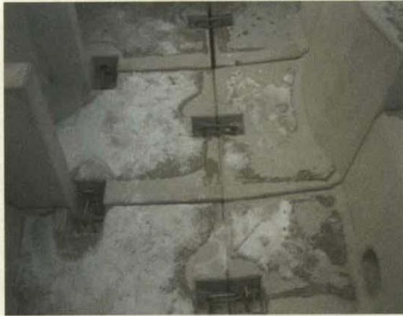
<그림 5-27> 어도블럭 샤클 조립 전경
