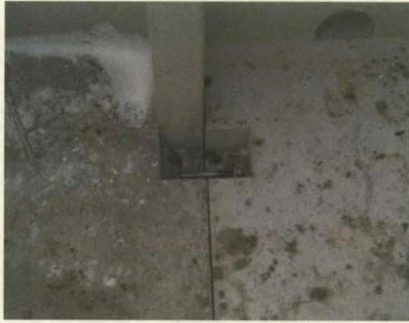
<그림 5-44> 어도블럭 샤클 조립 전경
