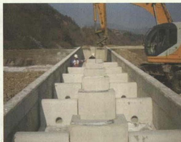
<그림 5-26> 어도블럭 조립 전경
