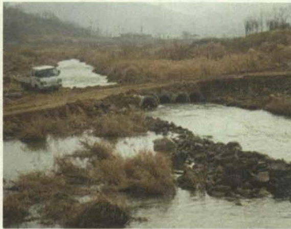
<그림 5-33> 가체절 및 임시도로 설치전경
