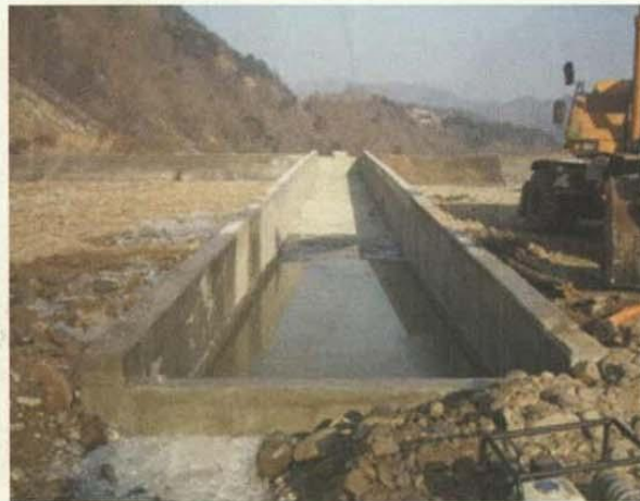
<그림 5-25> 바닥 및 벽체 콘크리트 타설후 전경
