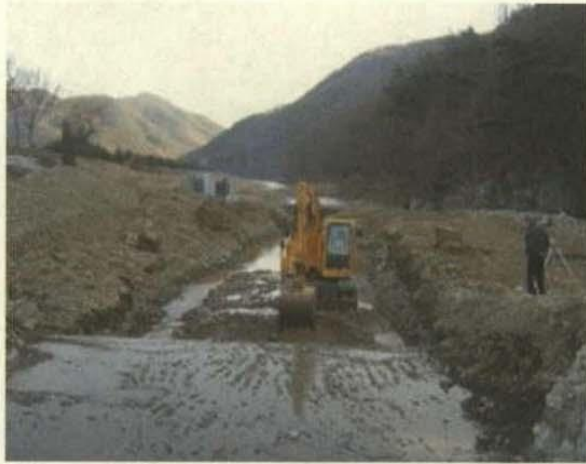
<그림 5-50> 취입보 취평 및 터파기 전경
