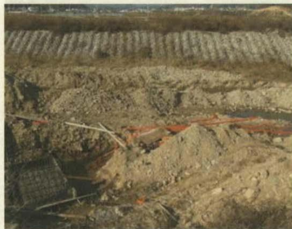
<그림 5-11> 가체절 및 펌핑 전경
