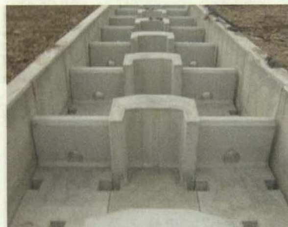
<그림 5-55> 어도블럭 조립 전경
