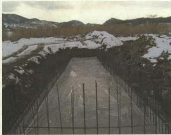
<그림 5-42> 바닥콘크리트 타설 후 양생전경
