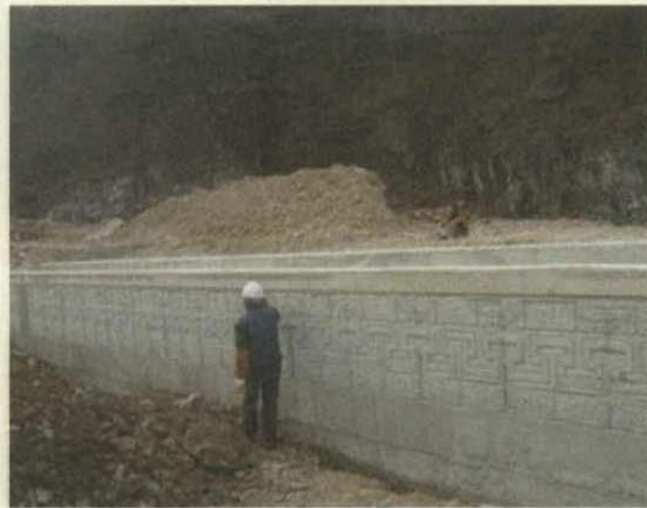
<그림 5-57> 벽체 표면 마무리 작업 전경
