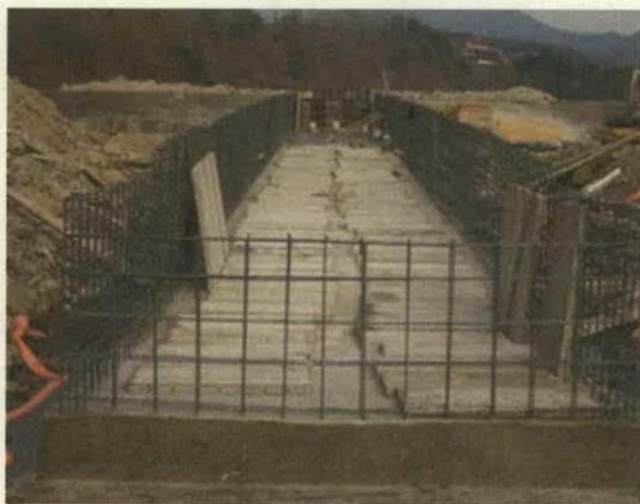
<그림 5-23> 벽체 철근조립 전경
