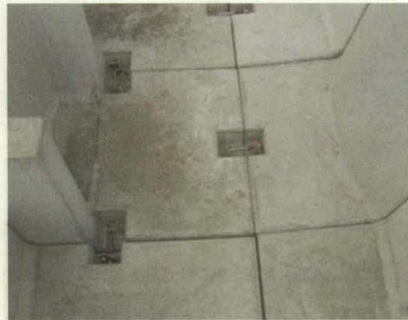
<그림 5-54> 어도블럭 샤클부 조립 전경
