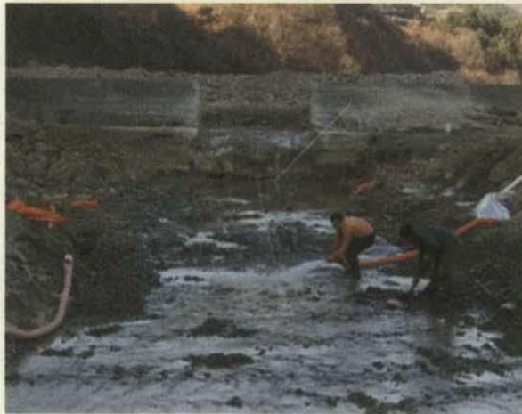
<그림 5-21> 터파기 완료 후 암반 청소 전경
