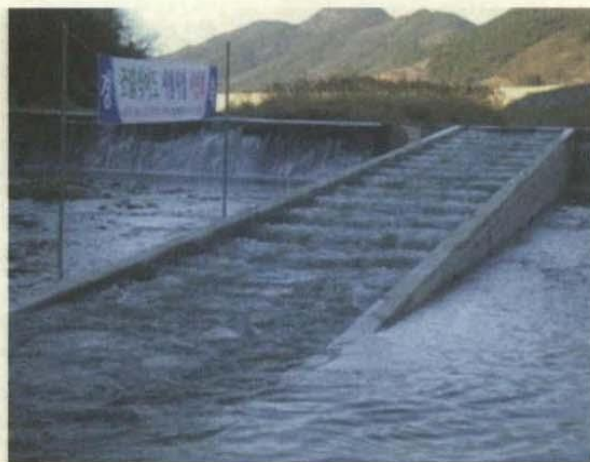
<그림 5-58> 어도블럭 설치 완료 후 통수전경
