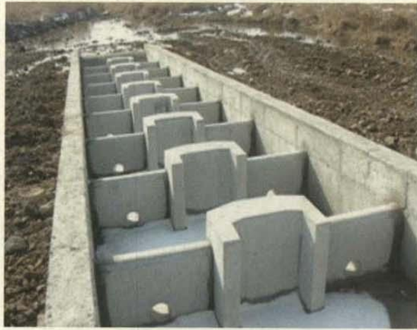
<그림 5-45> 어도블럭 조립완료 전경
