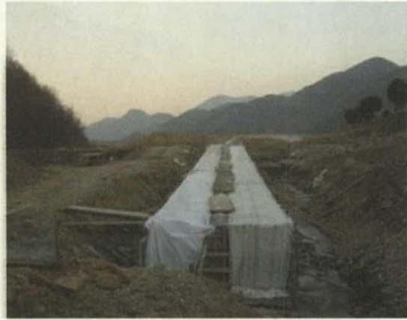
<그림 5-53> 콘크리트 타설후 양생 전경
