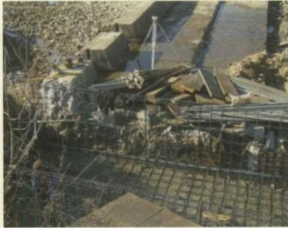
<그림 5-9> 터파기 및 바닥버림 콘크리트 전경
