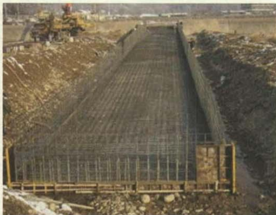
<그림 5-34> 바닥 및 벽체 철근 조립 전경
