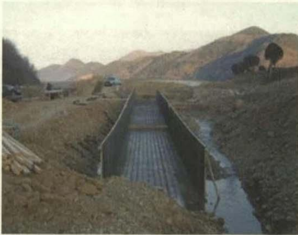
<그림 5-51> 바닥 및 벽체 철근 조립 전경
