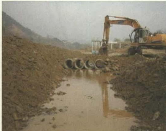
<그림 5-18> 가체절 및 임시 진입로 설치전경
