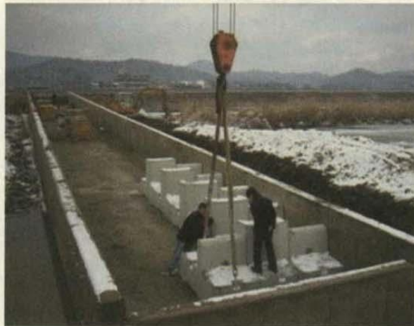
<그림 5-36> 어도블럭 조립 전경
