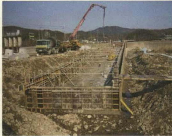
<그림 5-35> 거푸집 설치 후 콘크리트 타설전경
