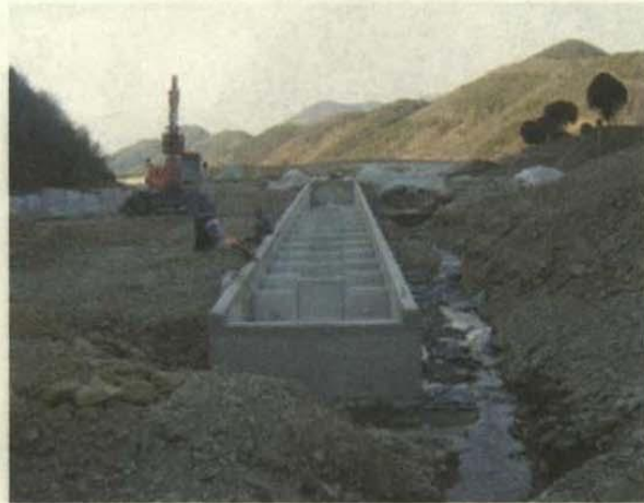
<그림 5-56> 어도블럭 설치 전경
