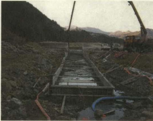
<그림 5-22> 바닥 콘크리트 타설 전경
