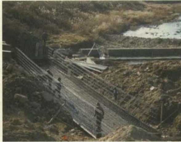
<그림 5-10> 바닥 및 벽체 철근조립 전경
