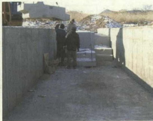
<그림 5-43> 어도블럭 조립 전경
