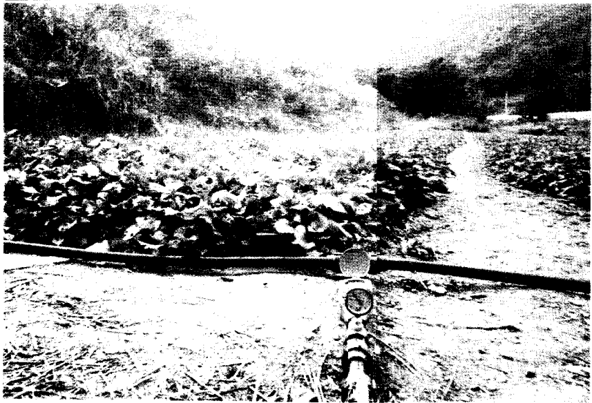
압력계와 유량계의 설치상황 (NO. 22번 포장)
