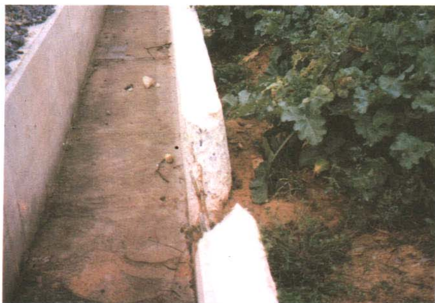
<사진 3-9> 배수로<봉호지구> (표면수를 유출시키기 위하여 부수었음)
