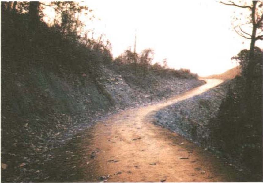
<사진 2-6> 농도사면의 토양유실 상태<대석지구>
