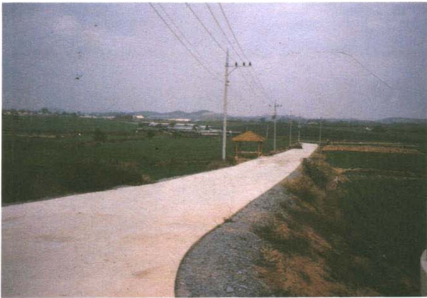
<사진 3-5> 간선농도 (콘크리트) <구학지구>
