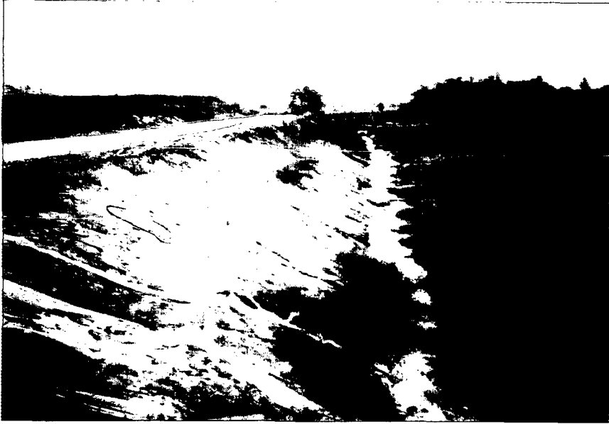
<사진 2-5> 농도사면의 토양유실 상태<봉호지구>
