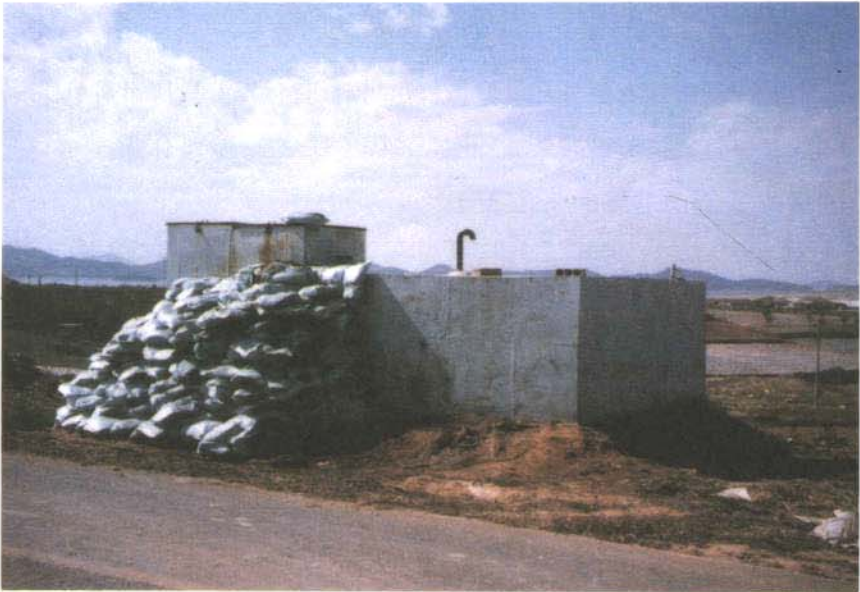
(b) 콘크리트 저수조 <성내지구>
