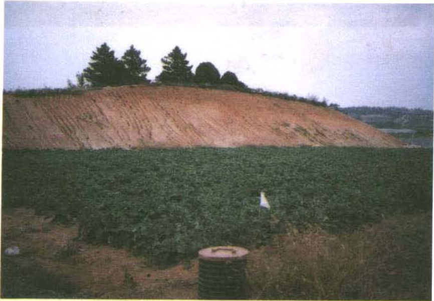
<사진 2-4> 사면의 걸리침식 상태<봉호지구>
