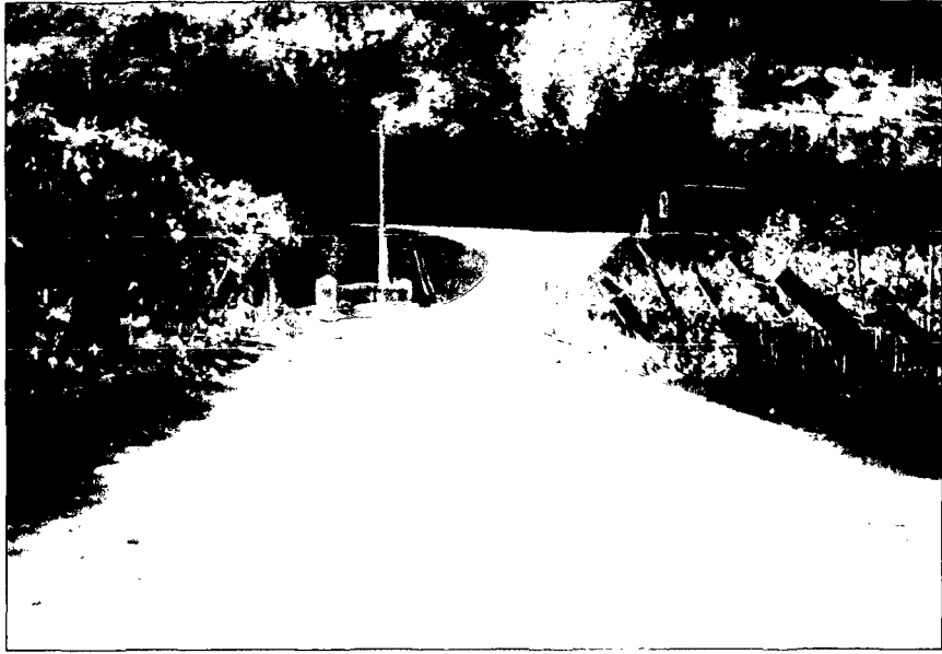
<사진 3-4> 진입도 (콘크리트) <서송원 지구>
