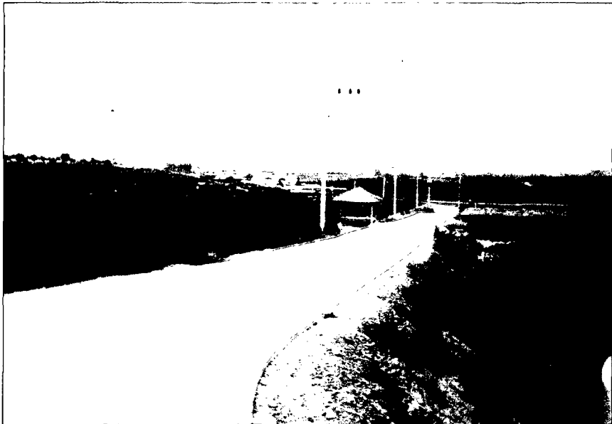
<사진 3-5> 간선농도 (콘크리트) <구학지구>
