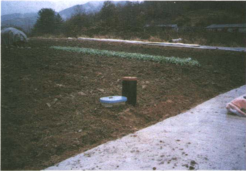
(c) III형 분수공의 수로계기보호공과 밸브 보호공이 2중으로 설치되어 있는 사례
