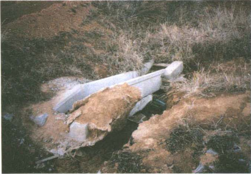
<사진 2-7> 사면보호공 설치<몽산지구>
