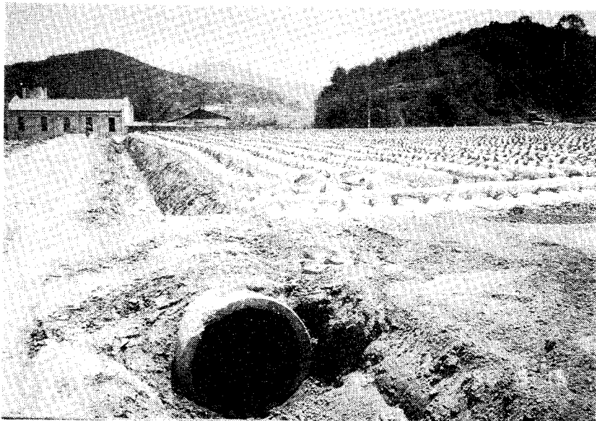
8. 월송지구(특작단지)-배수토관 매설 광경
