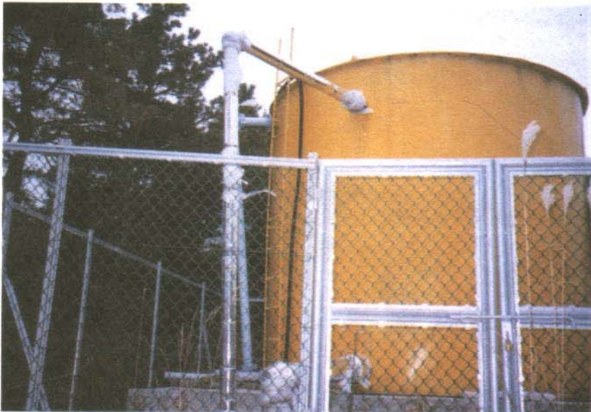
<사진 3-10> 저수조 주위의 철책 <산북지구>
