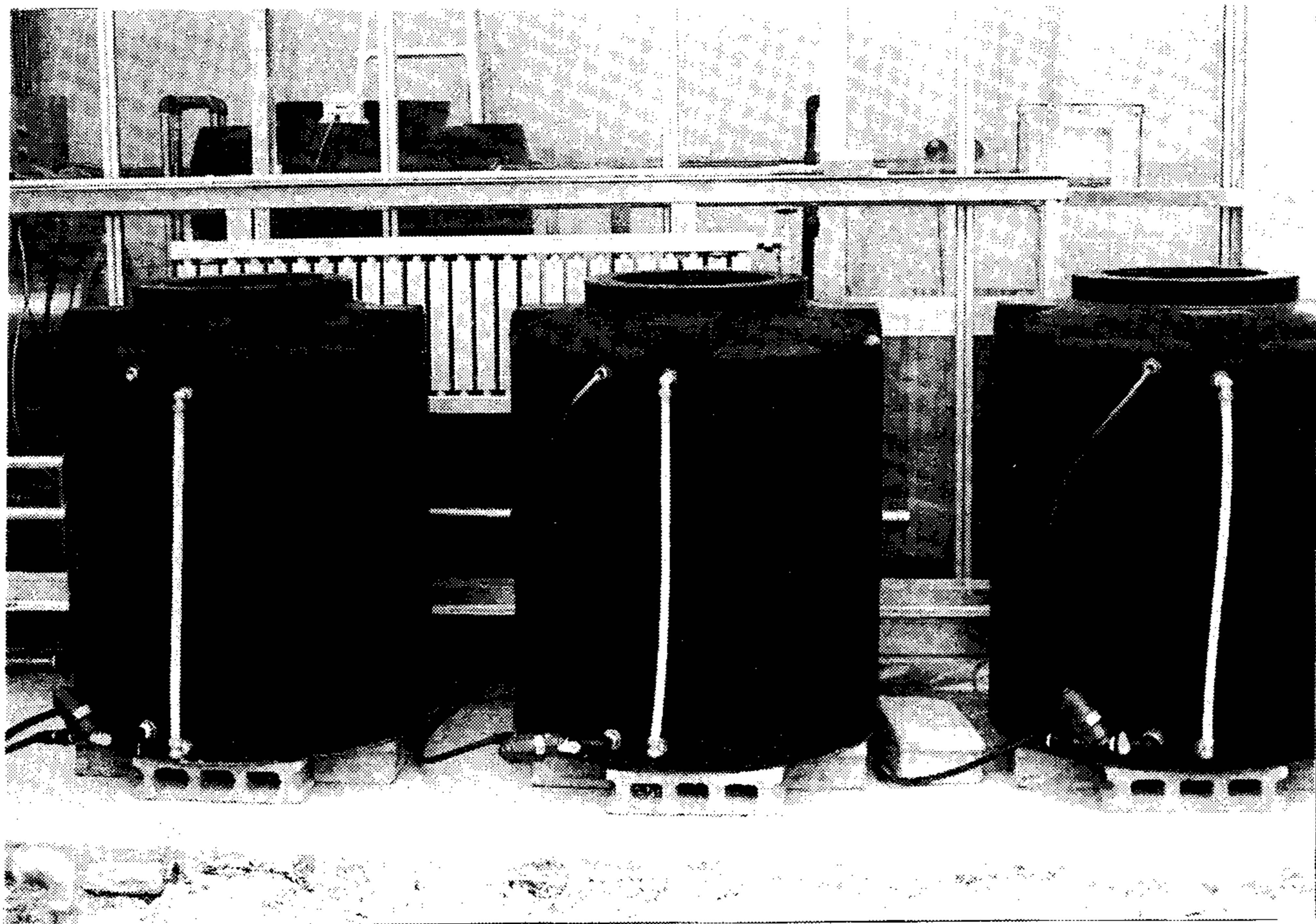
사진 3-8. 농축양액(액비)탱크 설치 모습
