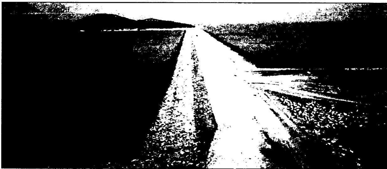
< 3공구 현장(성토완료, 마무리단계) >
