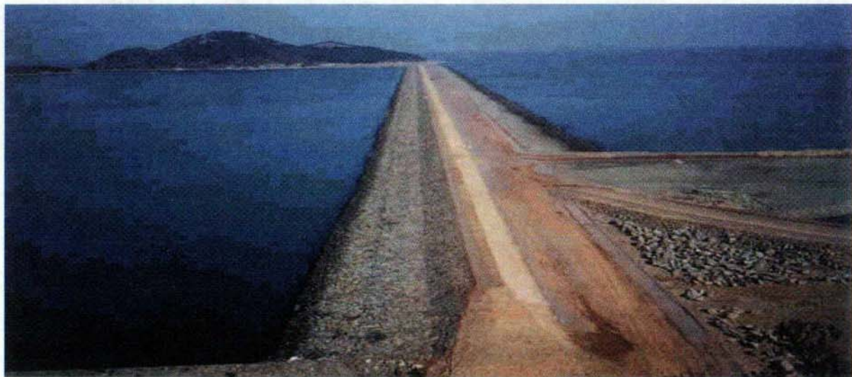
< 3공구 현장(성토완료, 마무리단계) >
