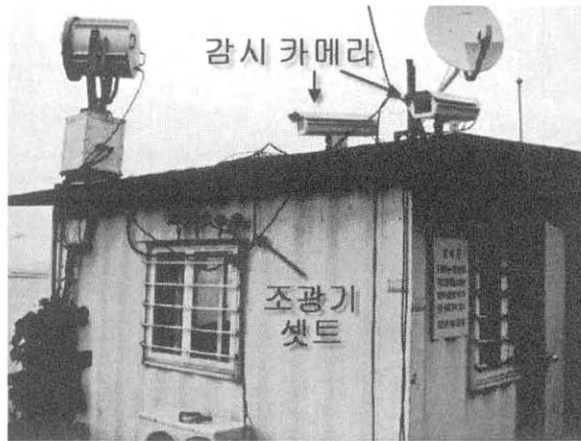
<그림 3-5-106> CCD 카메라 설치 모습
