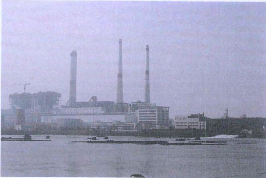
그림 3-1. 중국 황도화력발전소 전경(좌측: 소형 냉각탑, 우측: 온배수 배수구).
