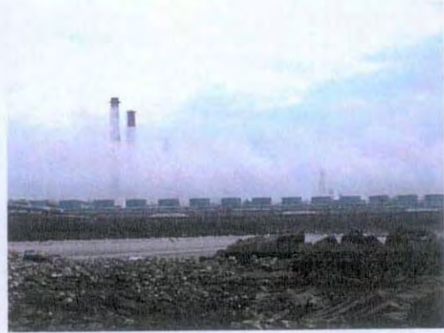
그림 3-3. 관류냉각방식의 온배수 배출(좌: 당진화력발전소)과 습식냉각탑의 수증기 발생(우: 현대중공업 대산복합화력발전소).
