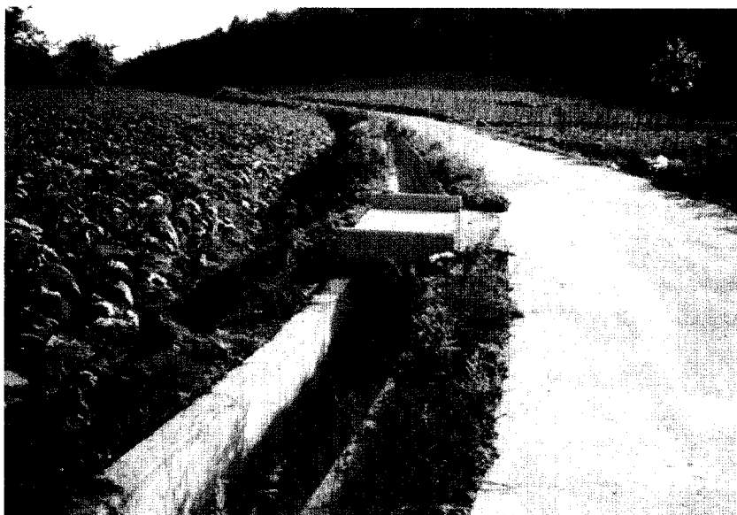
(도로 옆에 붙인 배수로)
