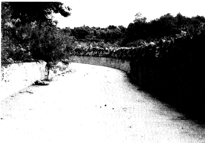
(도로 겸용 배수로)
