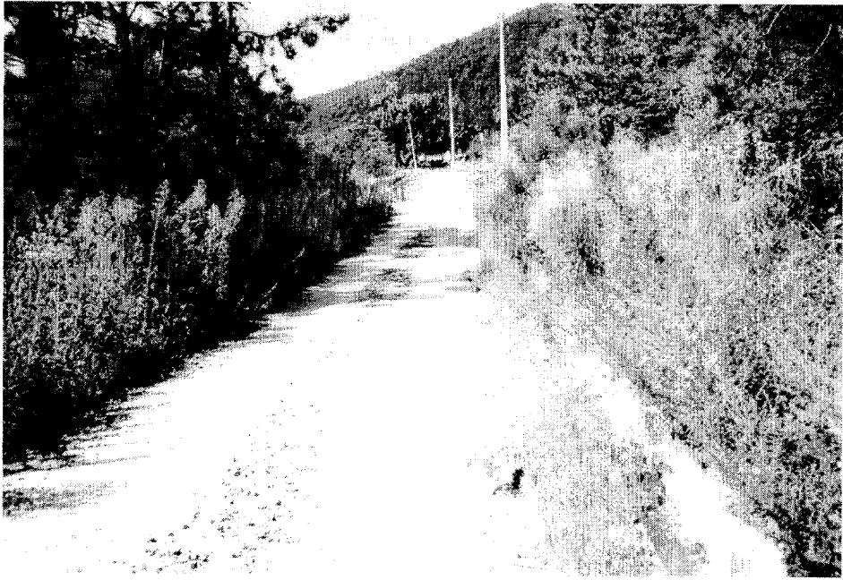
<기반정비시설이 잘된 도로>
