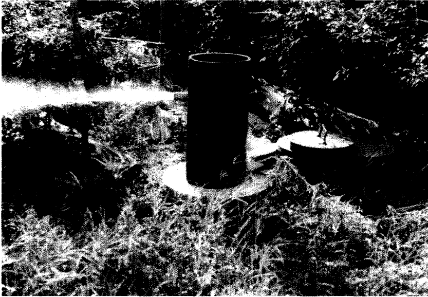
(폴리에틸렌관을 이용한 급수시설)
