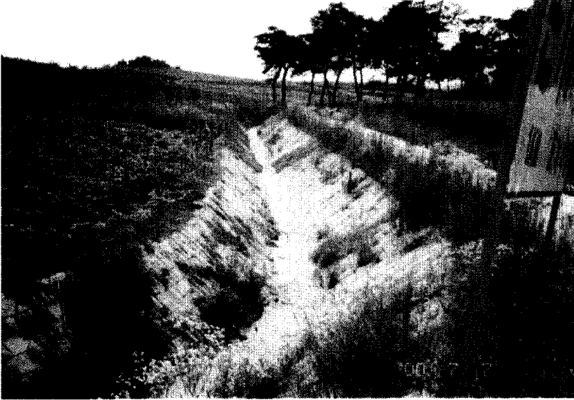
(콘크리트 블록 붙임 배수로)
