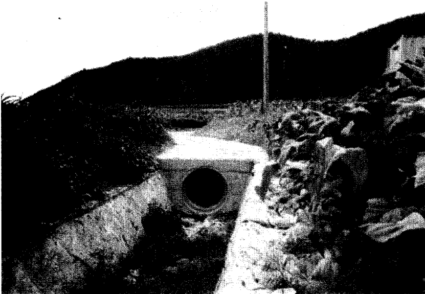
(콘크리트로 복개한 도로겸 배수로)
