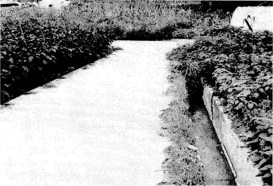
<도로 한쪽에 콘크리트 배수로를 설치하여 공사비 절감>
