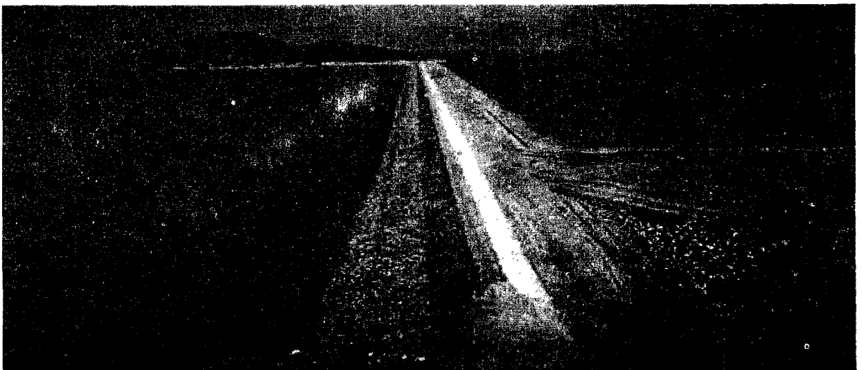
< 3공구 현장(성토완료, 마무리단계) >
