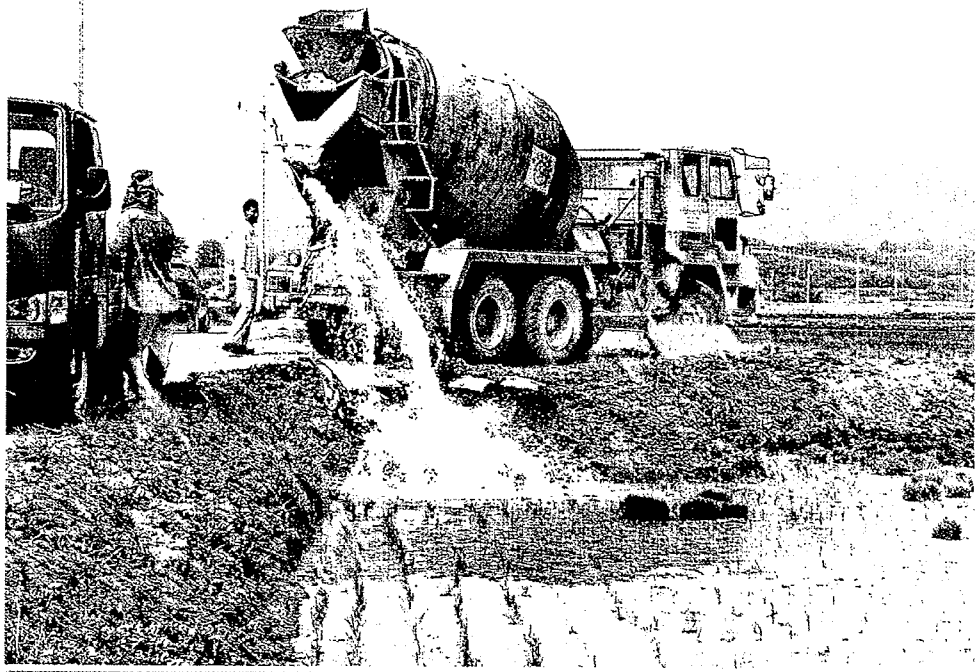
| 레미콘을 이용한 용수공급 <고창>
