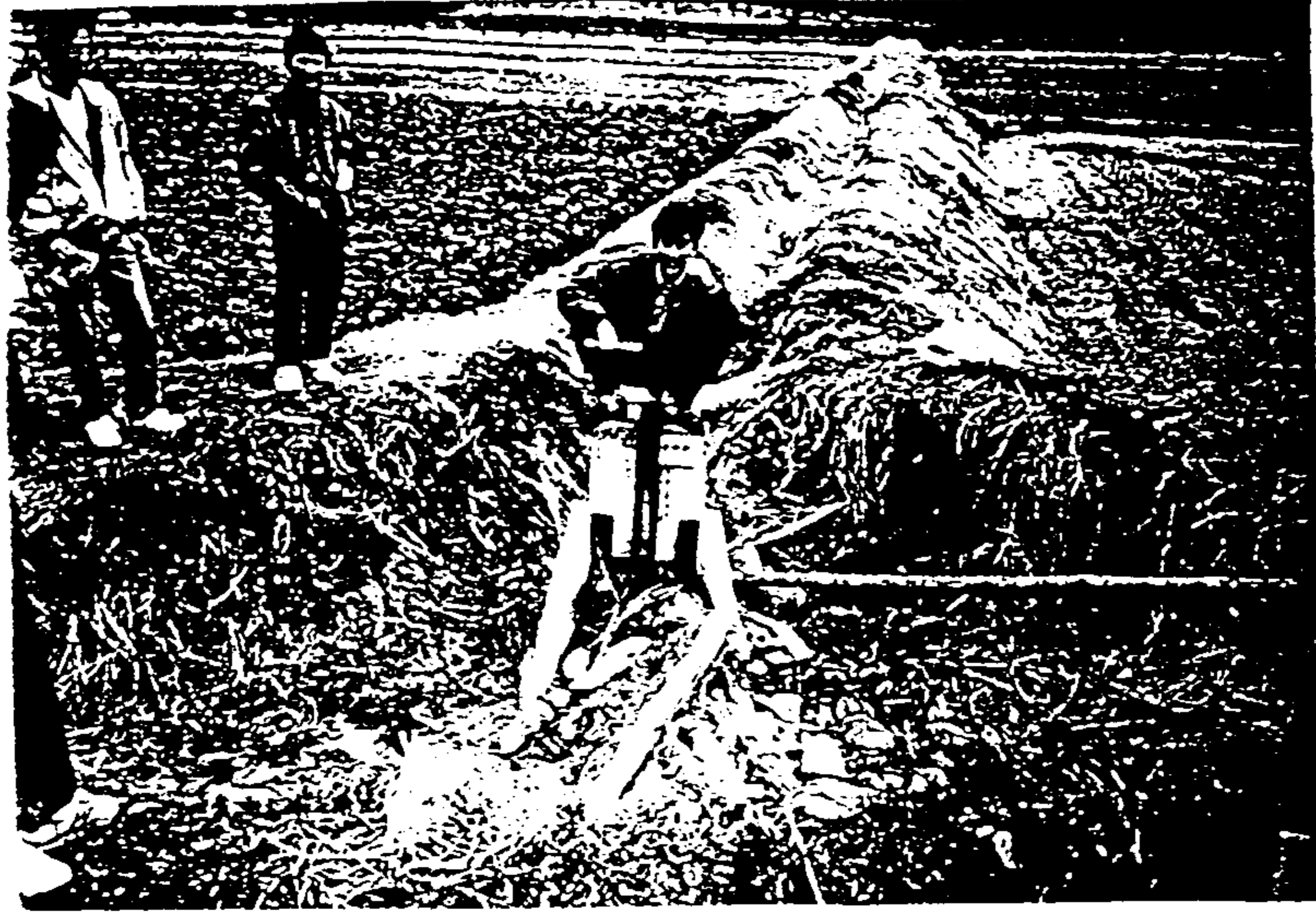
사진 4.19 분수공 C의 손상현황
