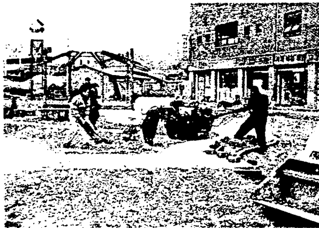
<그림 24> 투수콘 포장 과정
