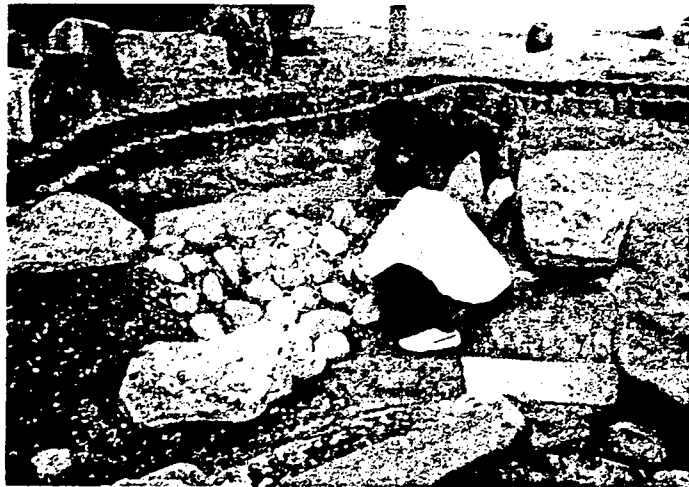
<그림 22> 수로 마감 공사
