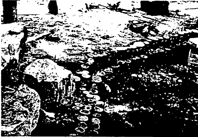
<그림 31> 시공 완료된 경계 말뚝
