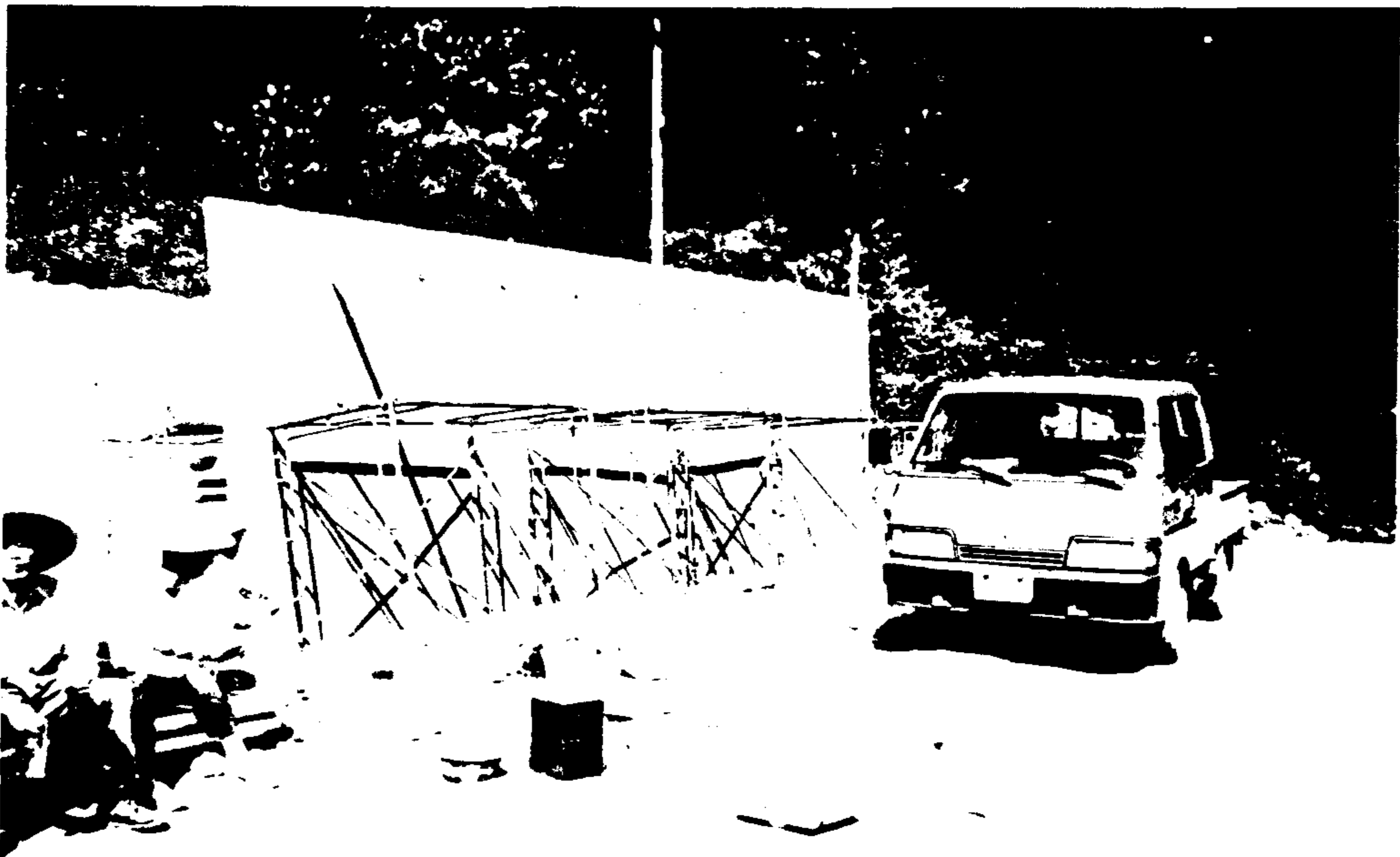
사진 6.3 벽체 샌드위치 패널의 조립을 위한 지지대 설치
