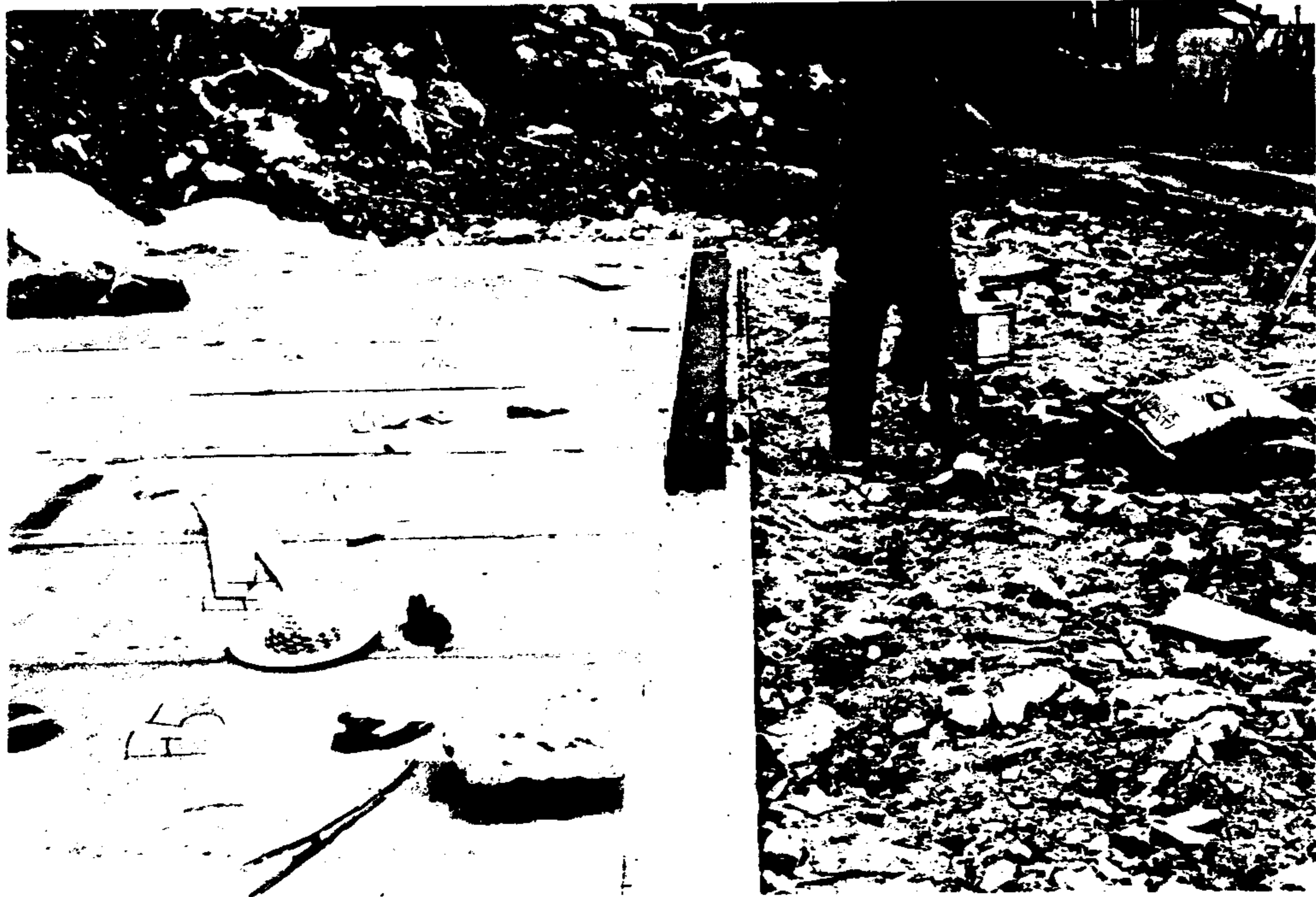
사진 6.3 벽체 샌드위치 패널의 조립을 위한 지지대 설치
