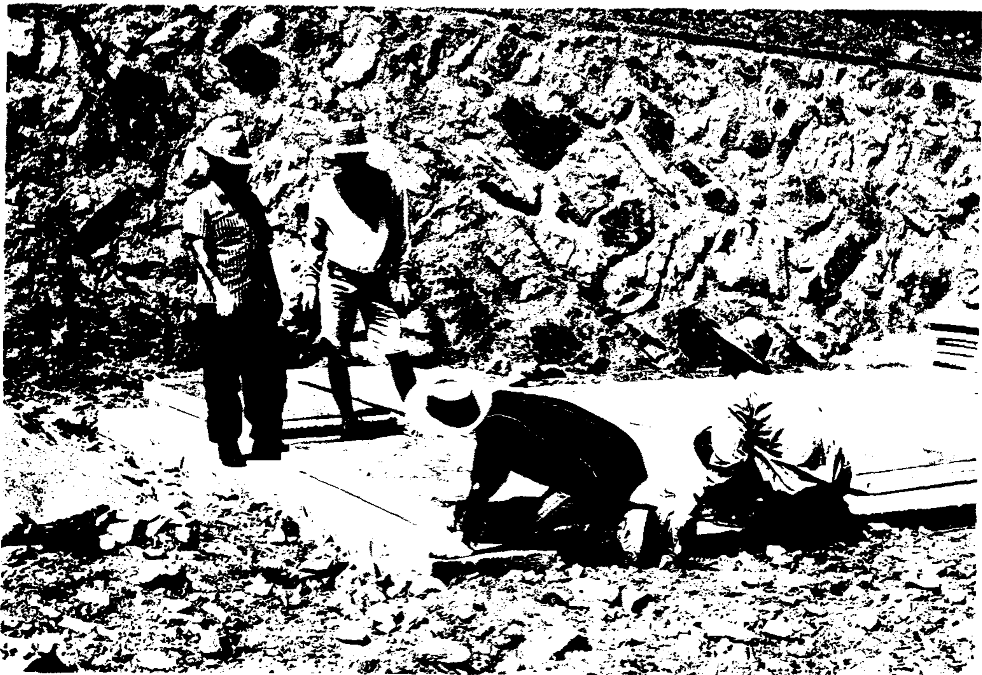
사진 6.2 바닥용 폴리머 콘크리트 샌드위치 패널의 조립
