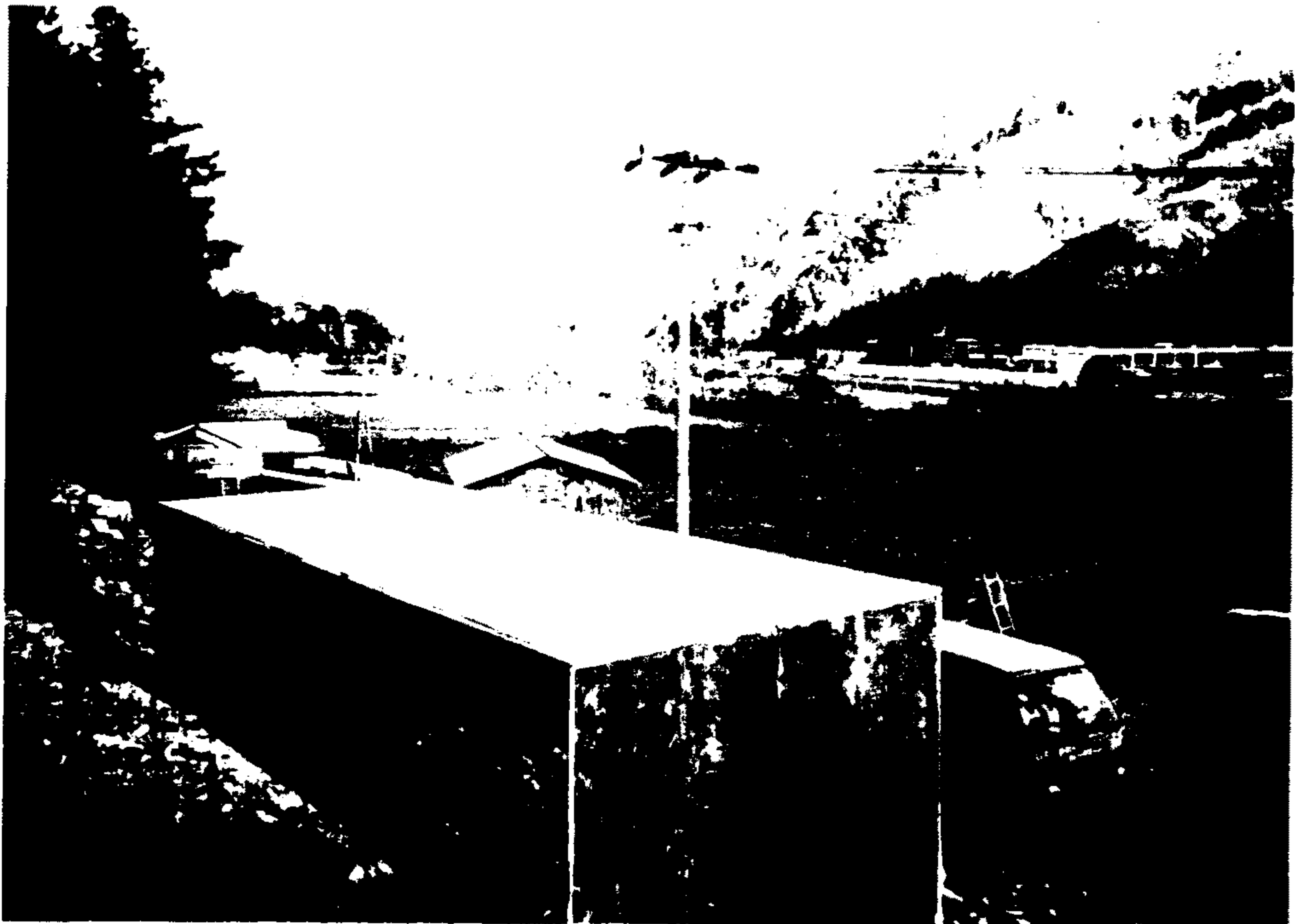
사진 6.8 기본적인 건축이 끝난 저장고의 전경
