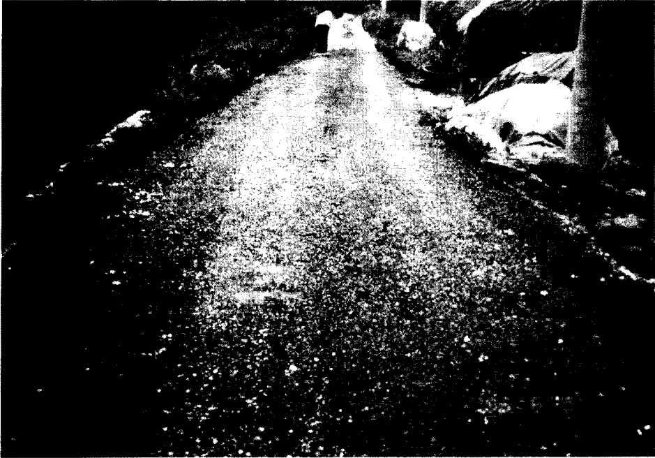
그림 4-35. 프라임 코트(Prime coat)를 뿌린 모습
