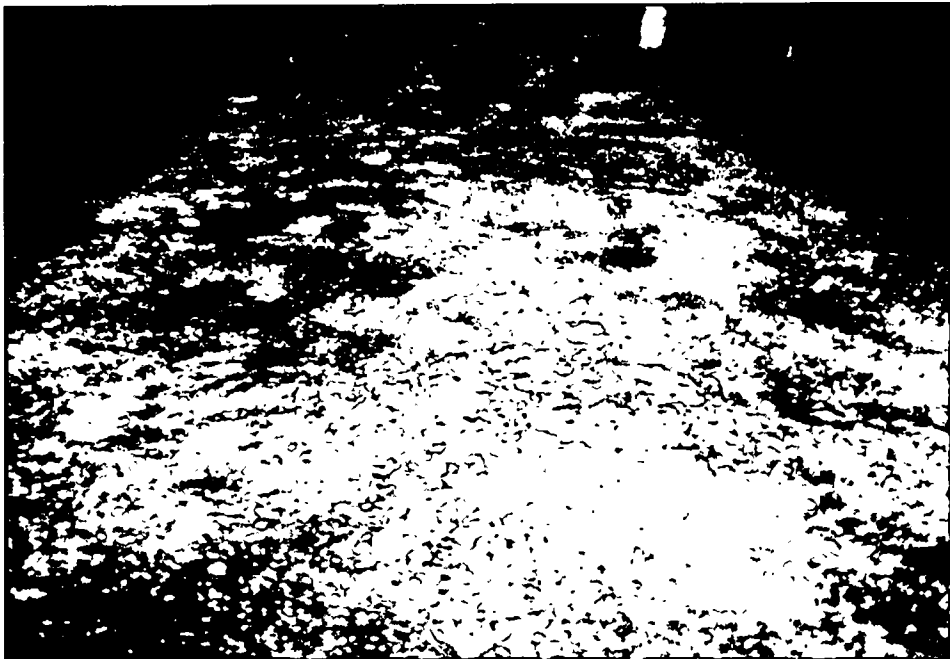
그림 4-38. 표면에 실코트를 위해 유제를 살포한 모습
