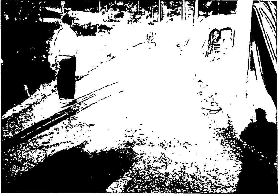
그림 4-39. 표면에 실코트(Seal coat)용 잔골재(5mm)를 뿌리는 작업
