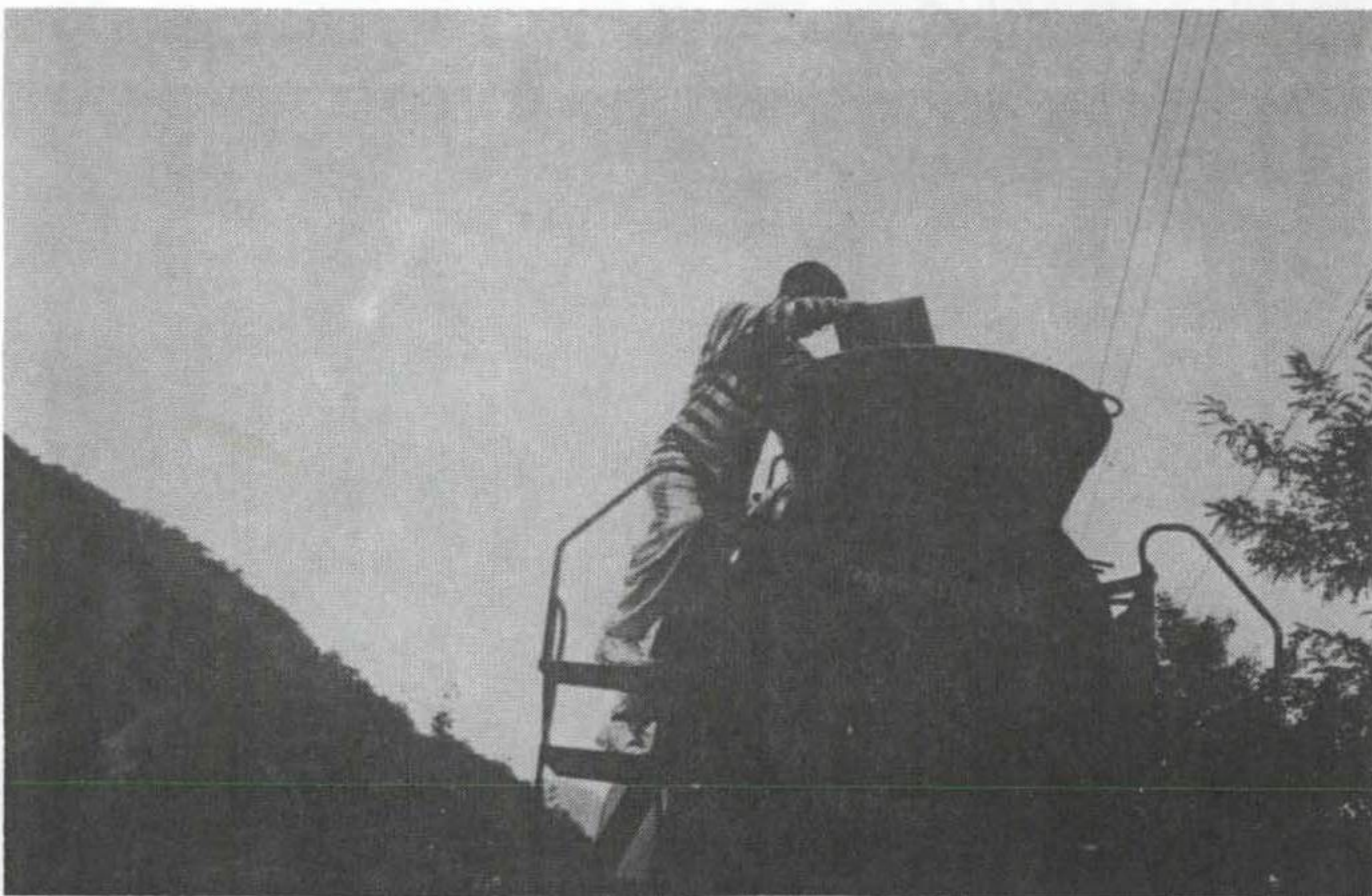
그림 4-10. 현장에서 레미콘 트럭에 혼화제를 첨가하는 모습
