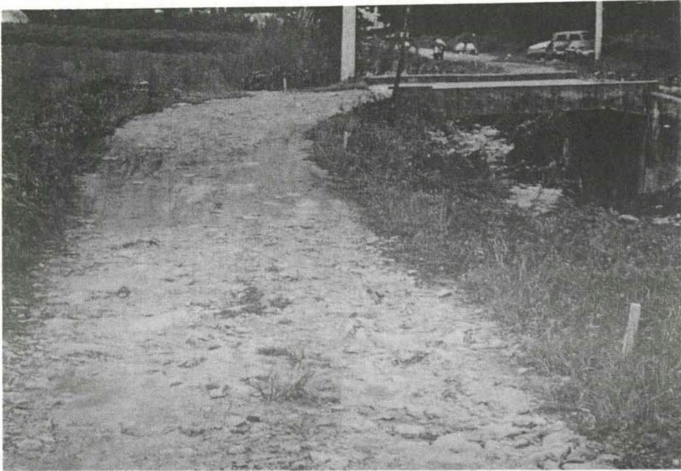
그림 4-9. 시험 포장할 현장의 노면 상태
