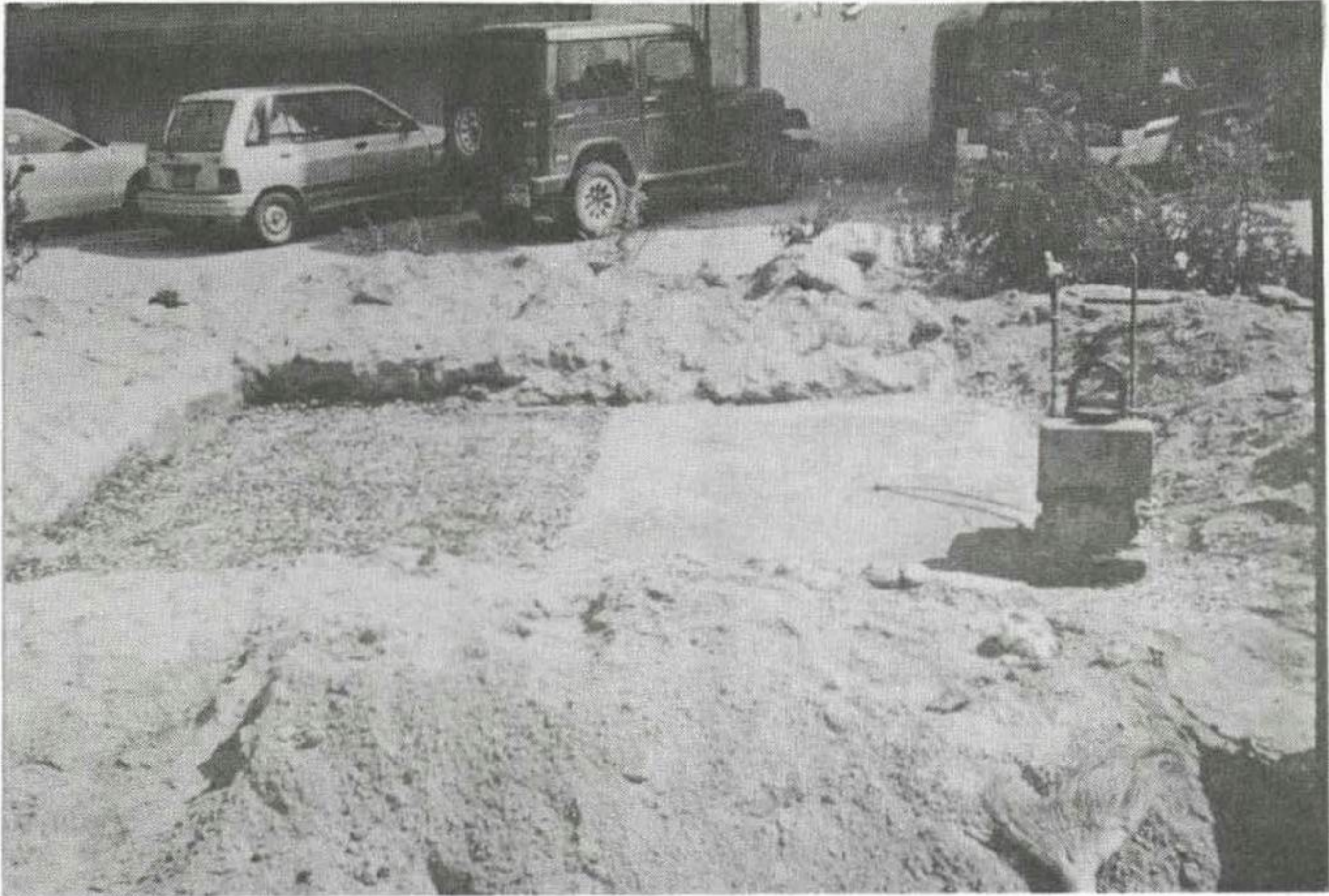
그림 4-2. 교내 시험 Pit에 보조 기층으로 재생골재를 15cm로 다진 광경
