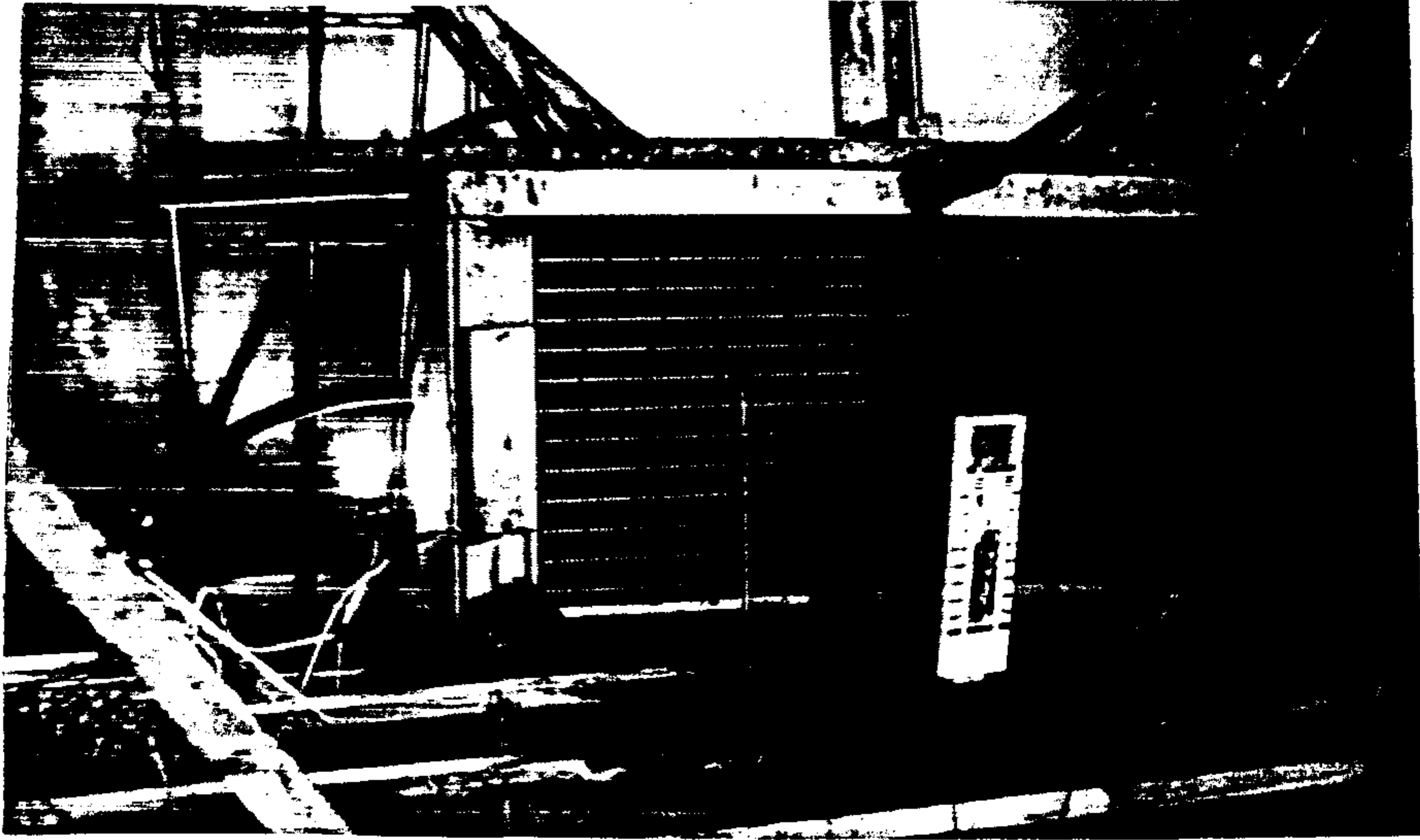
사진 5. 라디에이타 열교환 시스템
