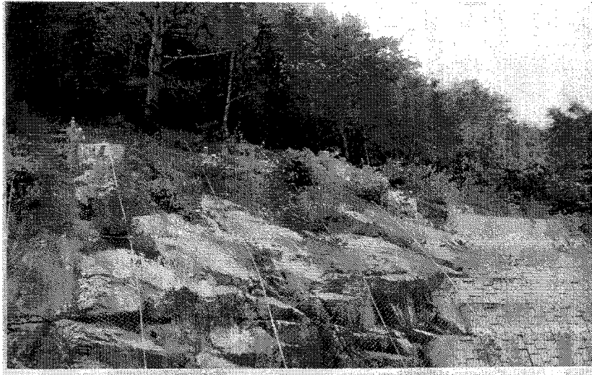
사진 2-12. 붕괴 및 낙석 방지를 위해 록볼트 및 콘크리트 구조물로 사면안정공사를 한 지역(화강암 지대 : 31번 국도변)
