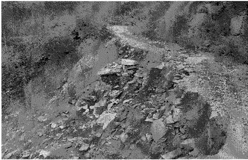
사진 2-25. 측구에서 유출수의 월류에 의한 임도 붕괴(함양 함양 죽암리)
