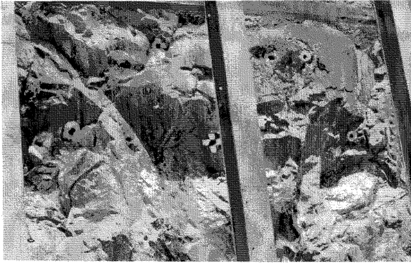
사진 2-17. 암석붕괴를 방지하기 위하여 기 시공하여 놓은 보링개소들
