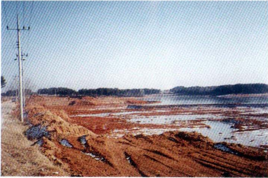
<그림 2-15> 준설시 가물막이 설치전경 (능제)
