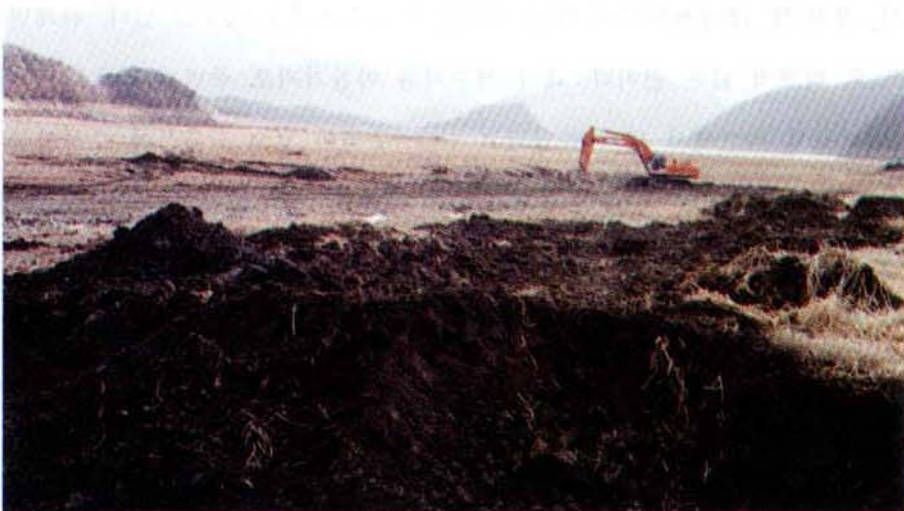
<그림 2-19> 저수지 준설전경(1) (경천제)
