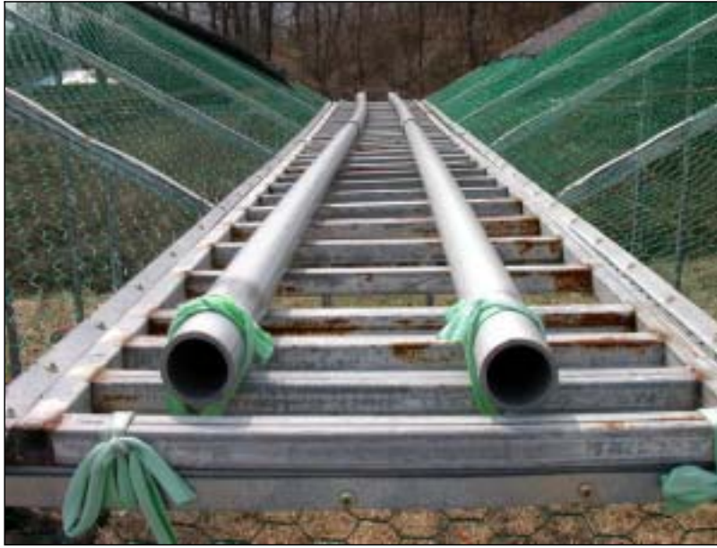
그림 59. 탈출 방지파이프의 설치 방법.
