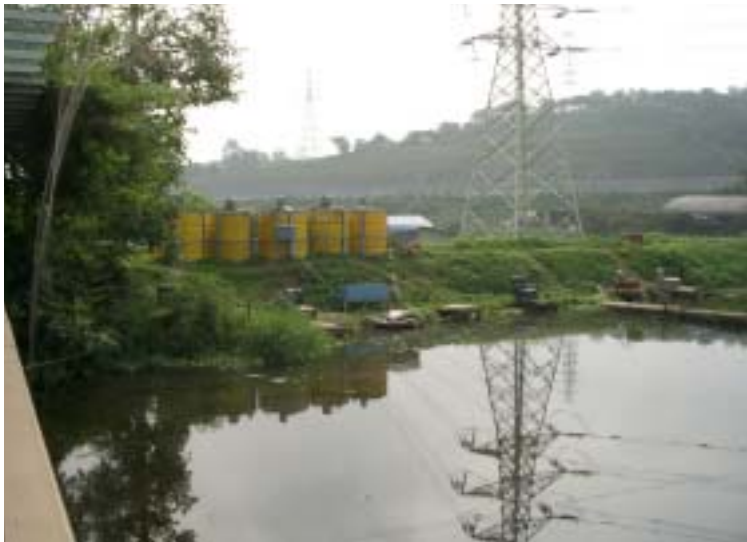
[사진 59] 모형저수지 반응조 배치전경
