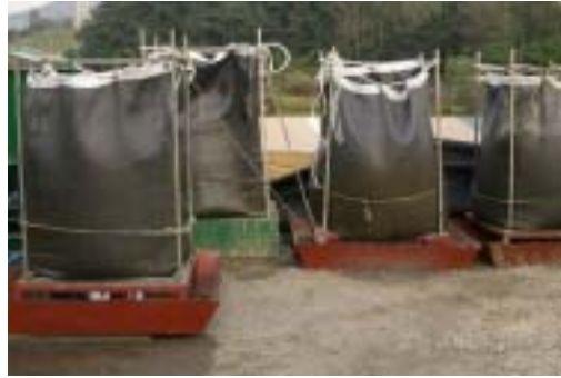
[사진 48] Geo bag(지지대,배수받침대 설치)
