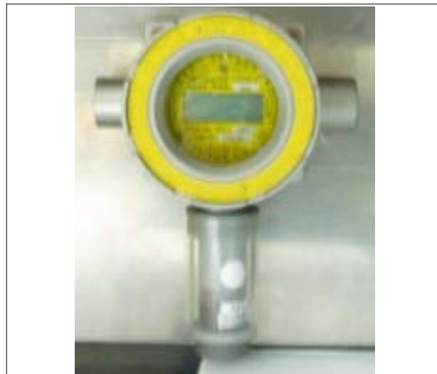
[그림3-45] 전기화학식 암모니아센서
