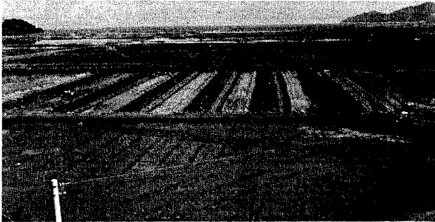
〈사진 5-2〉 <지하배수 제염암거 관매설 Ⅱ-1 및 Ⅱ-2 처리구 전경>
