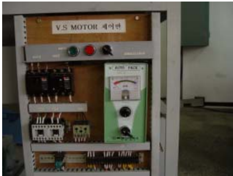
그림 4-9 V-S MOTOR 제어반
