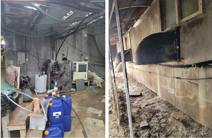
[그림 113] 바이오커튼의 설치과정(좌) 및 위치 (우)
