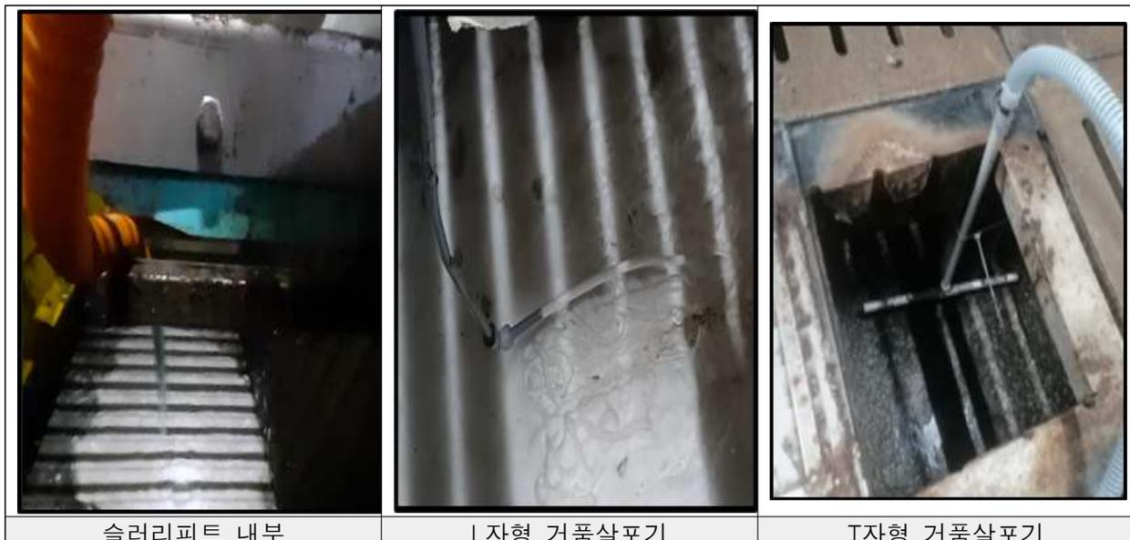
[그림 149] 국립 축산과학원 Test-bed 슬러리피트 내부 거품 도포장치 설치
