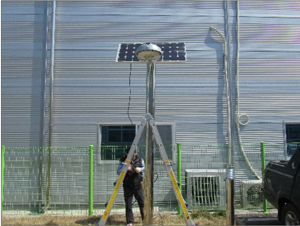
<해충방제용 LED 가로등 설치 작업>
