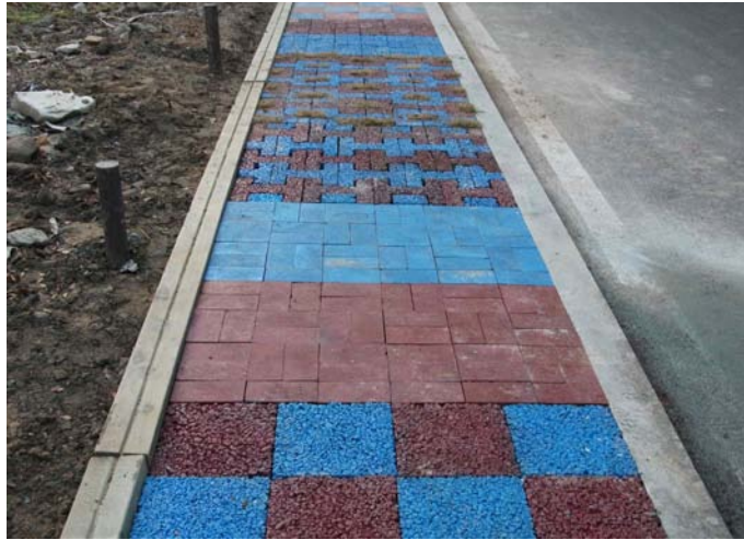
그림 3.5.13 형상별 Green Block 포장 시공 모습
