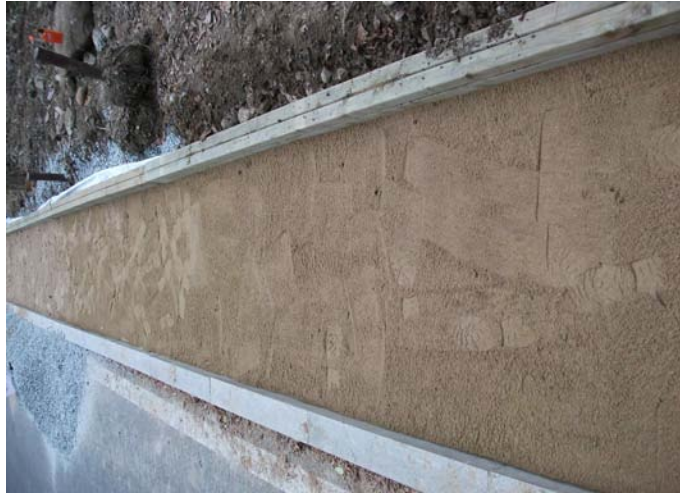
그림 3.5.9 블록 시공 전 받침 모래층 시공 모습
