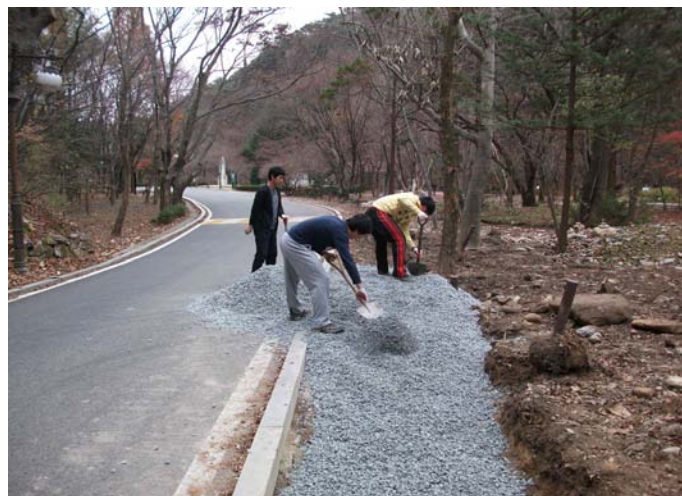
그림 3.5.6 입도 조정된 쇄석 골재 포설 모습
