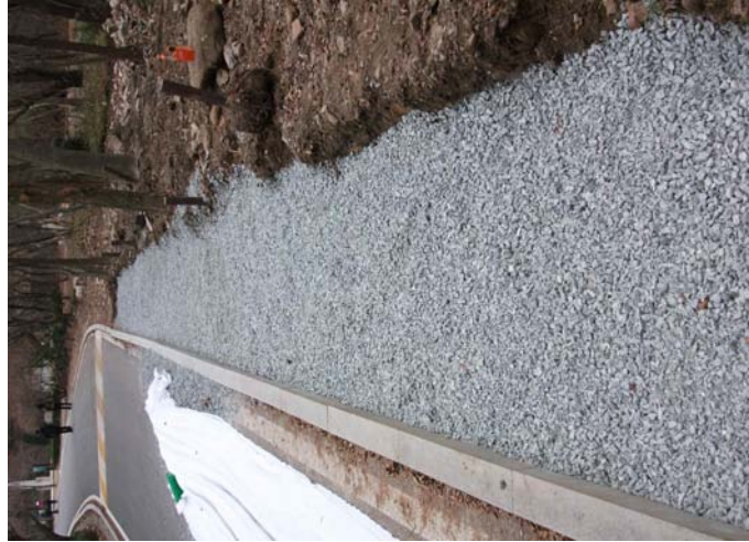
그림 3.5.7 입도 조정된 쇠석 골재 다짐 모습
