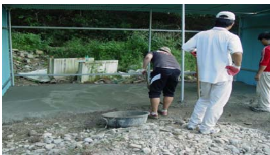
<퇴비화조 바닥 시멘트 작업>
