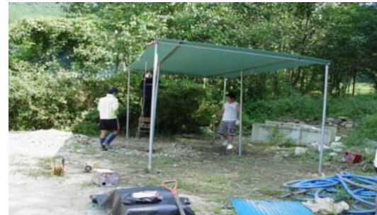
<퇴비화조 시공 전경>
