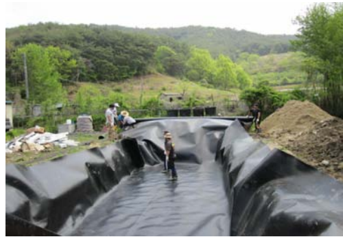
(혐기성조 차수막 설치)
