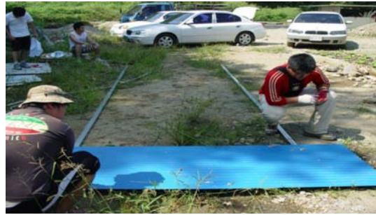
<퇴비화조 외벽 작업>
