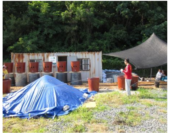
1차 처리조 설치
