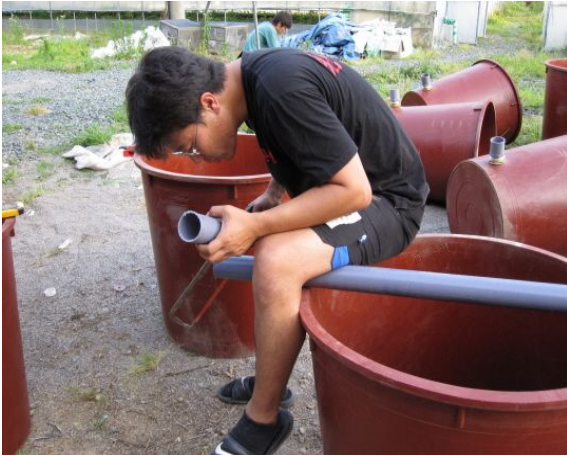
혐기성조/무산소조 배관 조립
