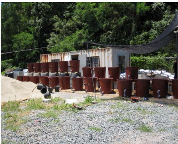
2차 처리조 설치
