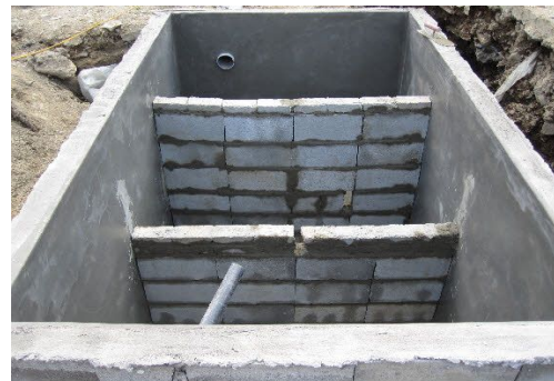
(방류수 집수조 설치)
