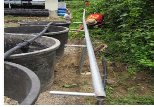
(축산폐수 유도관 설치)
