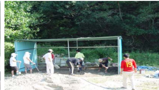
<퇴비화조 바닥 복토 작업>
