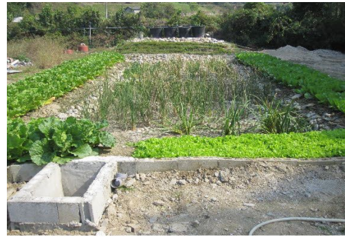
(현장 축산폐수처리장 완공전경)
