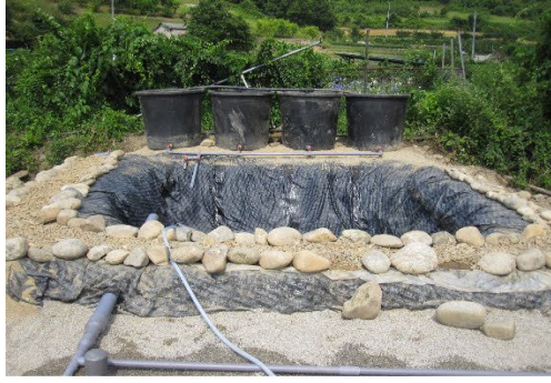
(수생식물여과조 및 활성슬러지조 설치)
