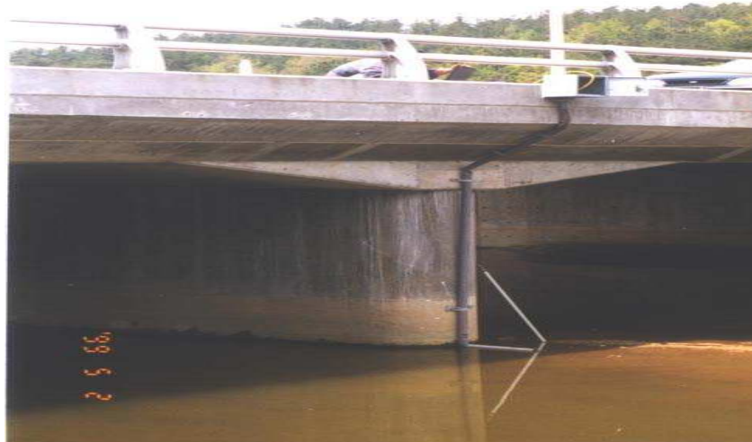
그림 6.2.1 댐유입하천에 설치된 수위계
