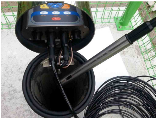
(c) 관정내장형 관측장비 설치
