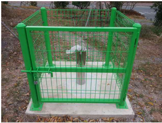
(a) 관측공 굴착, 기초, 보호시설 설치
