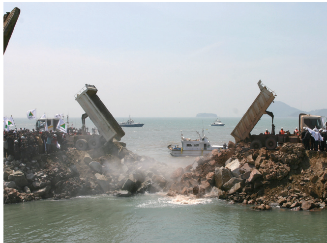
새만금 방조제 최종 끝막이 공사 (2006, 한국농어촌공사)
