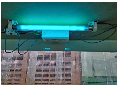
<그림.2-46> UV-C 살균 장치(좌), 사용한 UV-C 제원(우)
