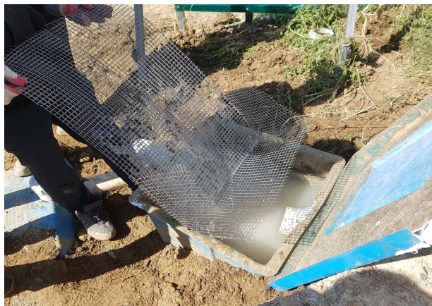
<그림 67. 전처리 스크린 제작 및 설치>
