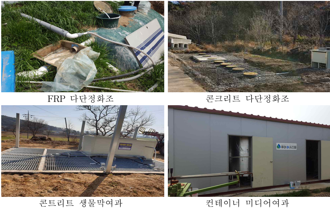
<그림 92. 기존 착유 세척수 정화처리 설비>
