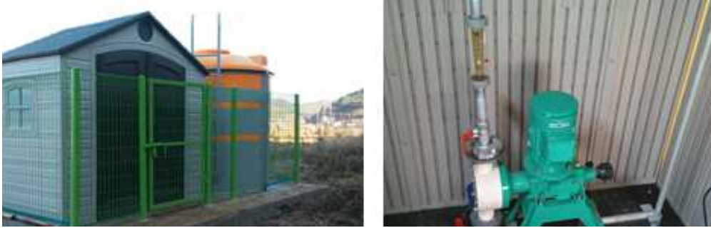
(그림 5.5-2) 응집침전장치 구성 예시(지상부)
