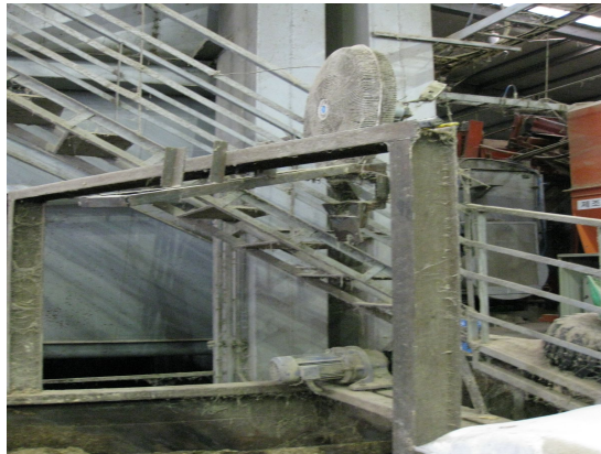
<그림 2-91> 공장 내부(TMF-A)
