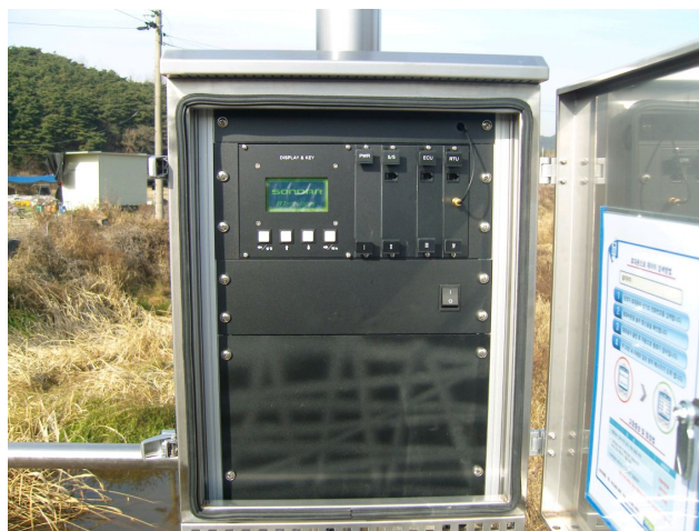
<그림 3-60> 유량계 합체 현장 설치
